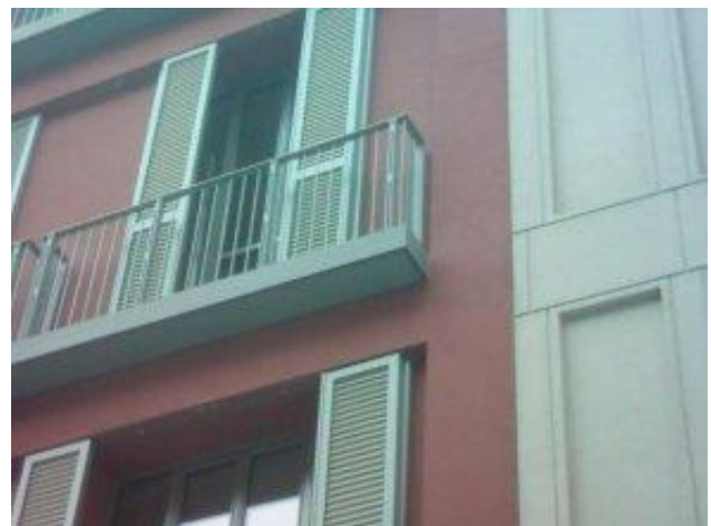
Esempio di facciata con correzione dei ponti termici. La soletta in c.a. del balcone ha un elemento di taglio termico e quindi la soletta del balcone è alla temperatura dell'aria esterna - edificio realizzato a Milano – misure inverno 2022/23
