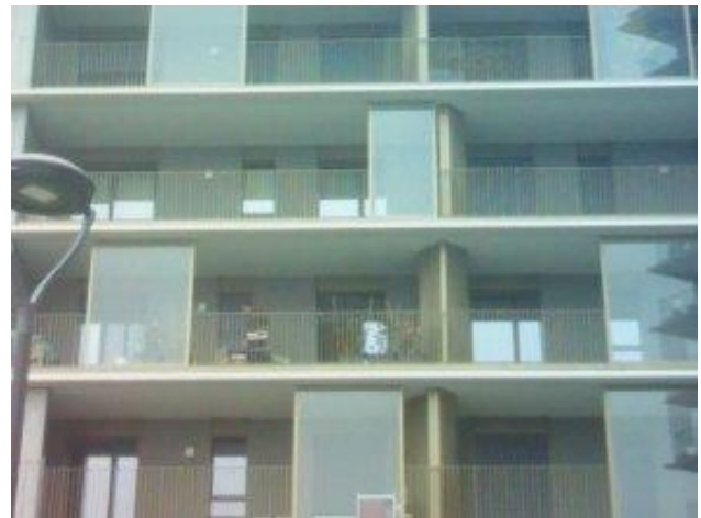
Esempio di facciata con correzione dei ponti termici. La soletta in c.a. del balcone ha un elemento di taglio termico e quindi superficialmente la temperatura è omogenea ( \Delta T < 1 \text{ }^\circ\text{C} ) come mostrato dai valori indicati dalla linea (massimo e minimo) - edificio realizzato a Milano – misure inverno 2022/23
