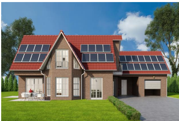
impianto a servizio di abitazione
