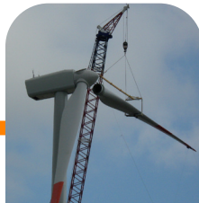
POSA IN OPERA: NAVICELLA, ROTORE, GIRANTE EOLICA
