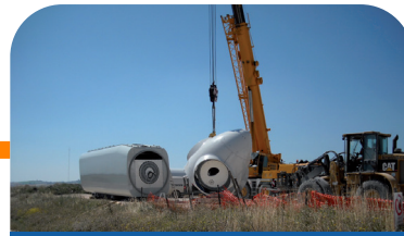
ARRIVO TURBINA: NAVICELLA
