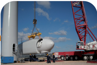
POSA IN OPERA: NAVICELLA, ROTORE, GIRANTE EOLICA
