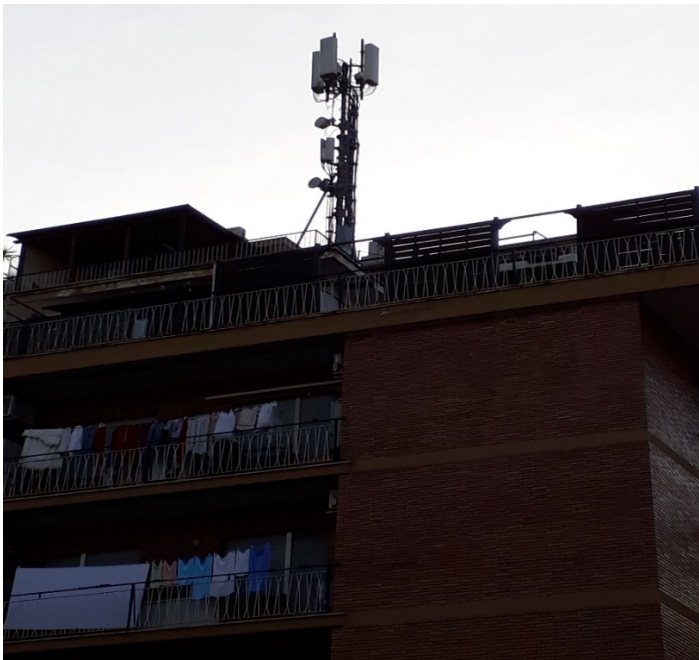
Figura n. 10 "Antenne di telefonia 5G – Via dei Crispolti n. 78"
