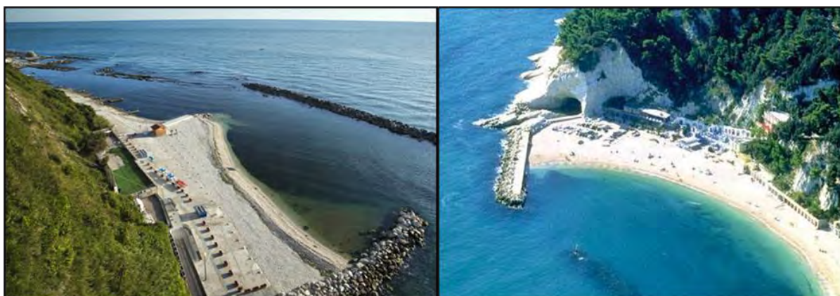
Fig 8.1 e 8.2- Esempi di litorale protetto da opere costiere dove sono stati effettuati i campionamenti (a sinistra Passetto ascensore e a destra Spiaggia Urbani di Sirolo)
