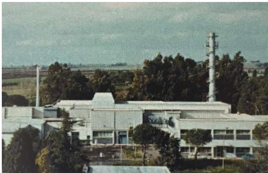
Il Laboratorio OPERazioni Calde (OPEC), entrato in esercizio nel 1962, presso il Centro ENEA Casaccia, è stato il primo laboratorio italiano in grado di eseguire analisi di post-irraggiamento su elementi di combustibile irraggiati a uranio metallico e/o a ossido di uranio con attività fino a 2000 Curies (74 TBq).
