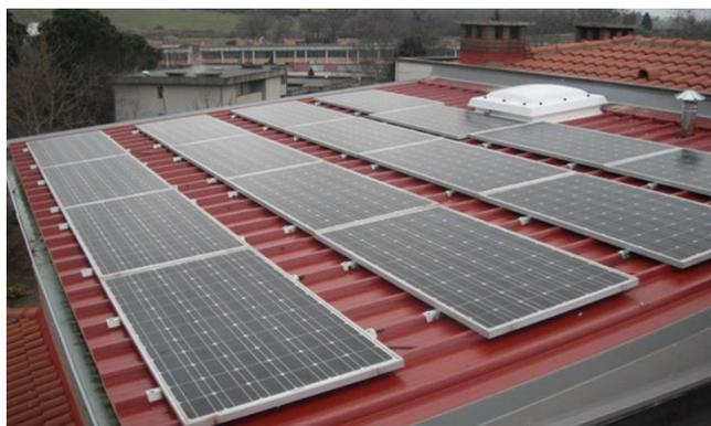
Spostamento moduli fotovoltaici - Al fine di migliorarne le prestazioni, l'impianto è stato spostato sul lastrico solare (fotografia a destra). In questo caso la realizzazione dell'intervento non ha avuto effetti sul mantenimento delle tariffe incentivanti riconosciute - Fonte: Direzione Verifiche GSE
