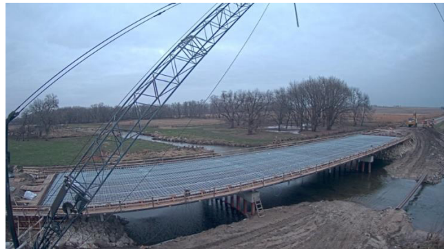
Figura 6.13 - USA - Buffalo Creek Bridge: ponte di 60 m circa con strutture di acciaio di impletato zincato a caldo e uso del tondino zincato nei componenti di cemento armato
