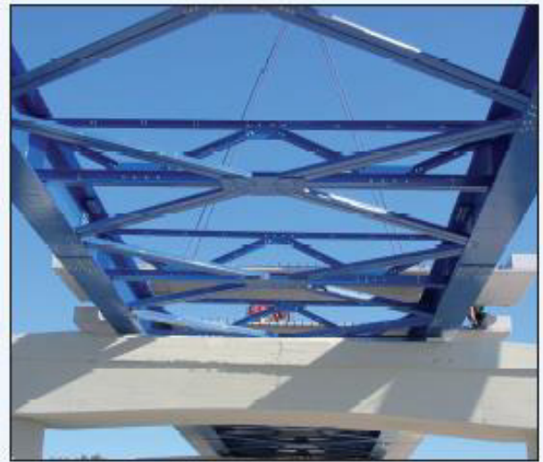
Figura 4.102 - Vista dell'intradosso del ponte preesistente e vista della nuova orditura metallica di un ponte sul Piave
