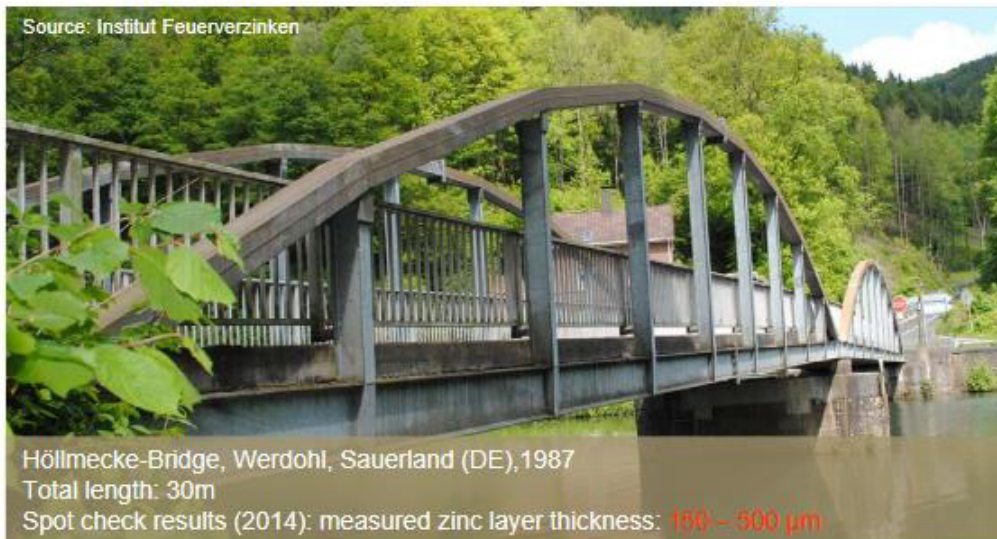
Figura 6.10 - Esempio di ponte in acciaio zincato che dopo 27 anni dalla realizzazione presenta uno strato protettivo di spessore compreso tra i 150 \mu\text{m} e i 500 \mu\text{m}
