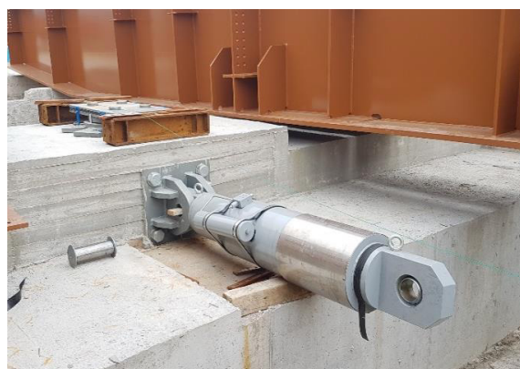
Figura 5.8 - Dissipatore sismico fluidodinamico
