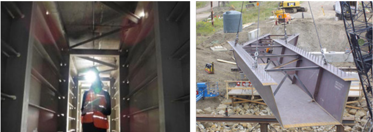
Figura 4.39 - Immagini di cantiere
