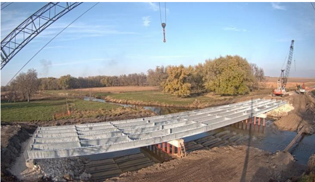
Figura 6.13 - USA - Buffalo Creek Bridge: ponte di 60 m circa con strutture di acciaio di impletato zincato a caldo e uso del tondino zincato nei componenti di cemento armato
