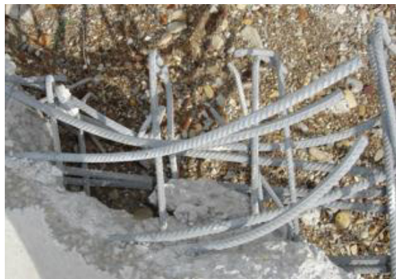
Figura 6.14 - Port Elisabeth (Sud Africa) - Armature zincate a caldo dopo oltre 40 anni di servizio (1964-2005). Ponte pedonale a pochi metri dal mare abbattuto per cessata utilità. Questa particolare circostanza ha consentito di verificare che le armature zincate erano ancora in perfetto stato
