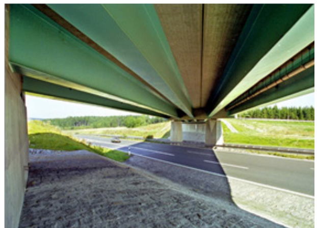
Figura 4.19 - Immagini di realizzazioni per impalcati multi-trave a profilo laminato semplice
