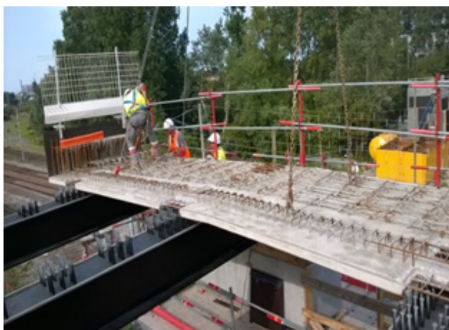
Figura 4.17 – Immagini di cantiere per il sistema di travi accoppiate
