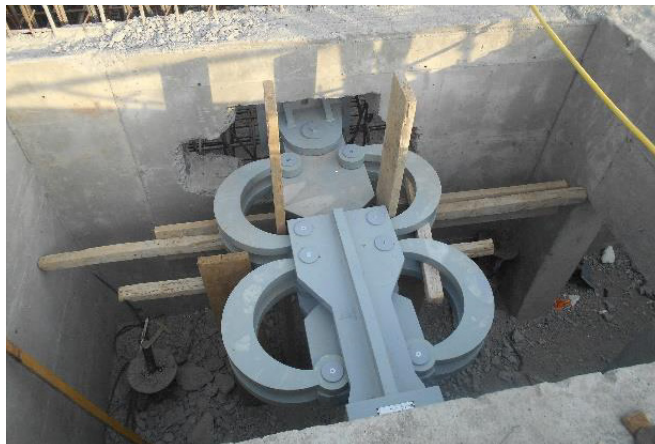
Figura 5.7 – Dissipatore sismico isteretico
