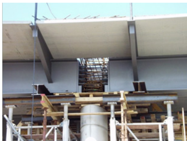
Figura 4.17 – Immagini di cantiere per il sistema di travi accoppiate
