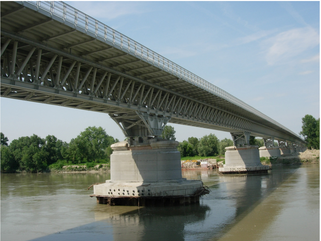
Figura 4.92 - Esempio di ponte a trave reticolare continua su più appoggi: Ponte sul fiume Po – SS9 (2009-2010 – Piacenza, luce tot: 810 m, campata max: 76 m)
