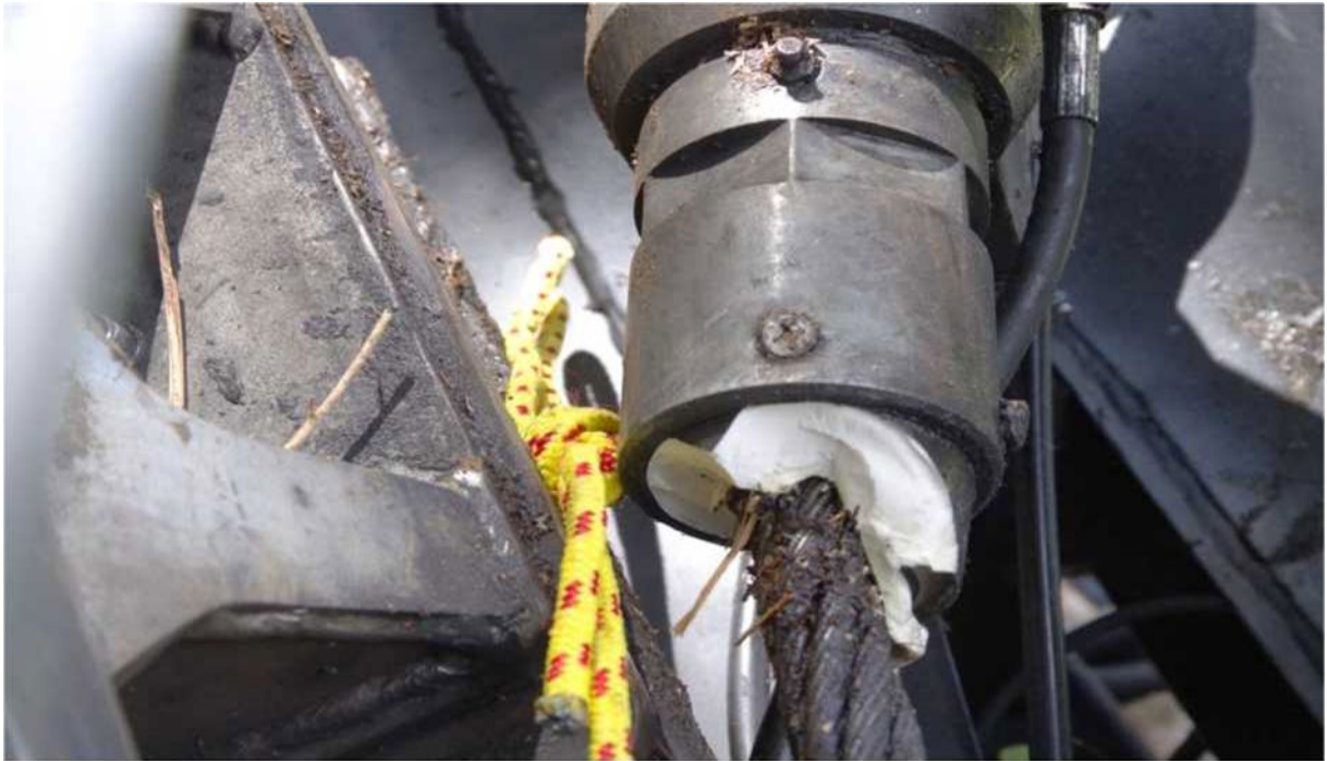
Figura 9 - Testa fusa della fune traente inferiore; esecuzione 14.03.2017 scadenza 14.03.2022 (fonte Digifema).
