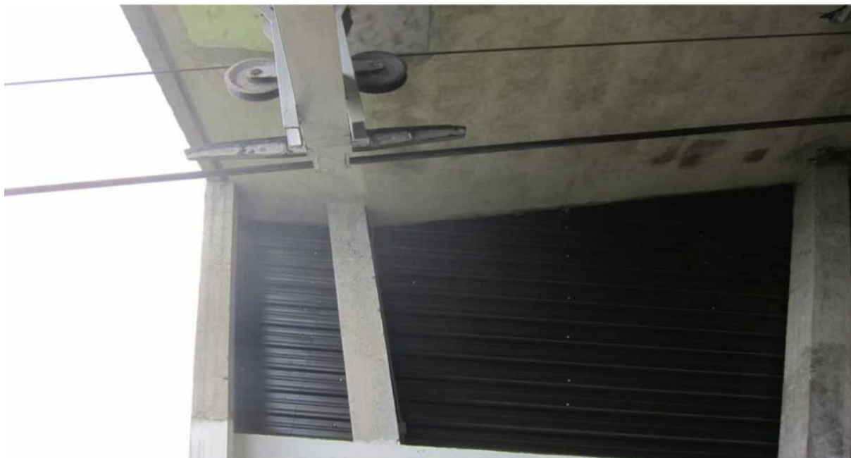
Figura 11 - Fune portante della cabina 3 saltata dalla scarpa di avanzamento. Fune di soccorso sui rulli di guida uscita stazione (fonte Digifema).
