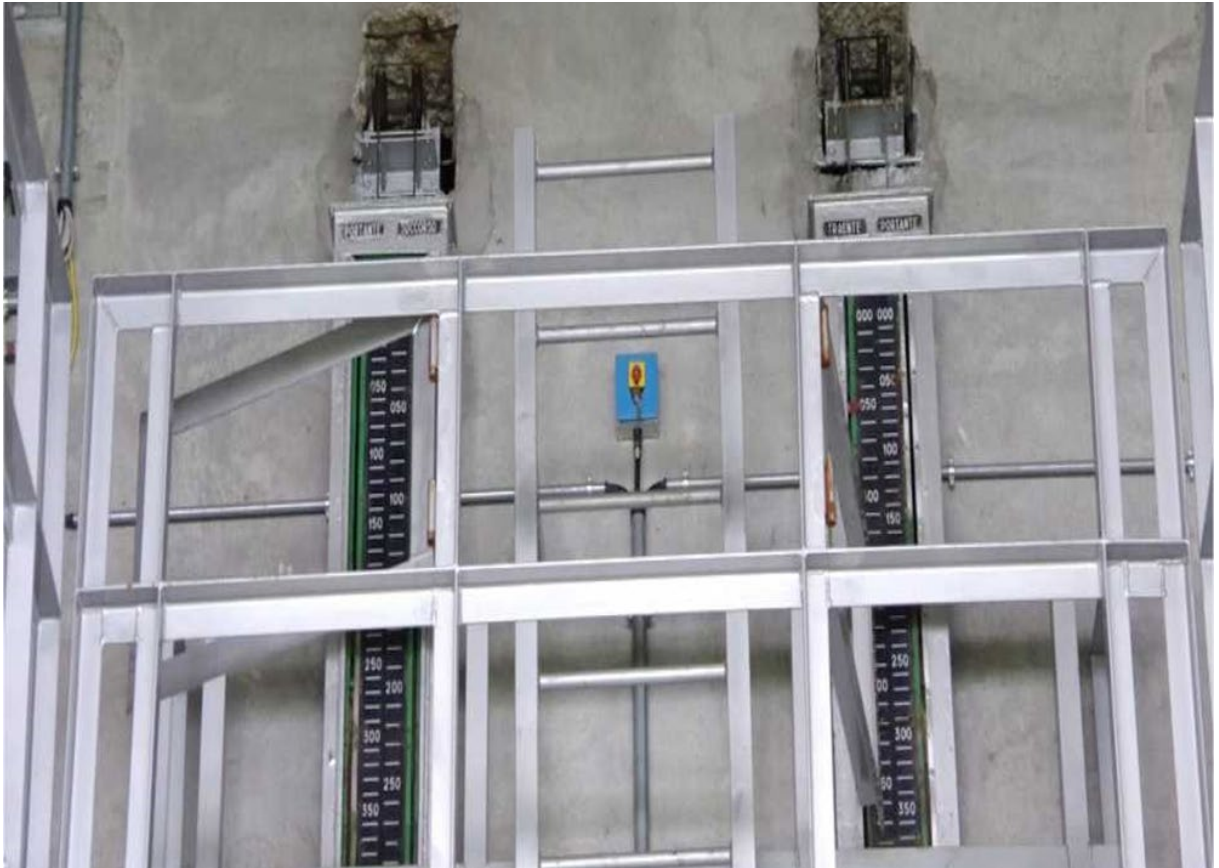
Figura 12 - Scale graduate. A dx scale di escursione del contrappeso della fune traente e della portante lato cabina 4. A sx scale di escursione della fune di soccorso e della fune portante lato cabina 3 (fonte Digifema).
