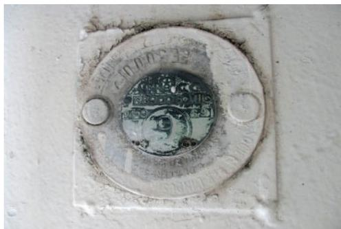
**Figura 6:** Esempio di vecchia targa di attrezzatura a pressione
