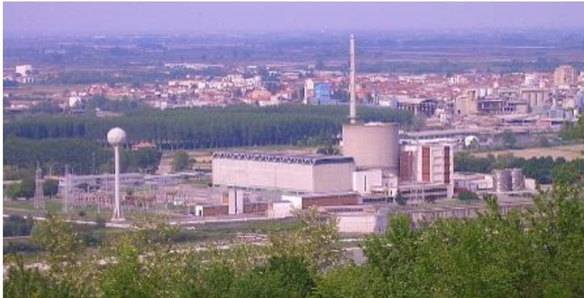
La centrale elettronucleare “Enrico Fermi” di Trino (VC), dotata di un reattore nucleare ad acqua pressurizzata Westinghouse del tipo PWR da 870 MWt (272 MWe), entrò in esercizio commerciale il 1/1/1965 e fu fermata il 21/3/1987, dopo aver prodotto complessivamente circa 25 miliardi di kilowattora. Con delibera CIPE del 26/7/1990 fu disposta la chiusura definitiva della centrale.
