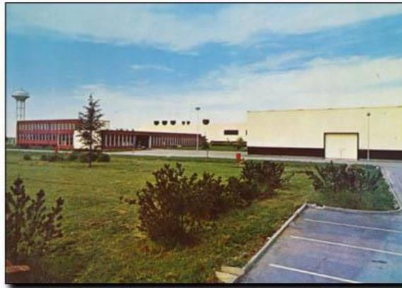
L'impianto di Bosco Marengo fu realizzato allo scopo di fabbricare elementi di combustibile nucleare per reattori ad acqua leggera a partire da ossidi di uranio a basso arricchimento. L'impianto è stato esercito dal 1973 al 1995 dalla Fabbricazioni Nucleari S.p.A. (FN), fabbricando combustibili per le centrali nucleari italiane (ricariche della centrale di Garigliano, prima carica e ricariche per la centrale di Caorso, ricariche per la centrale di Trino) e per reattori esteri.
