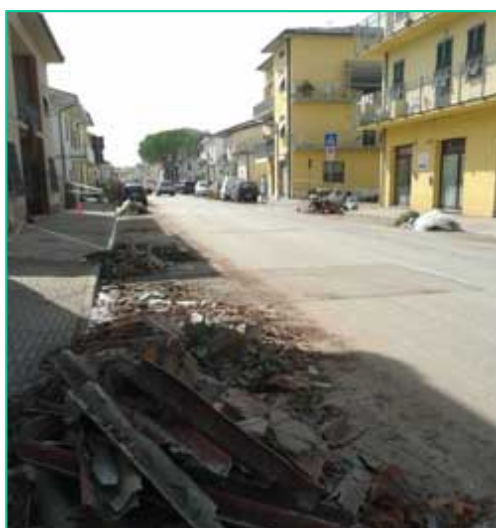
Figura 26 Crollo e dispersione della copertura in cemento-amianto a Cerreto Guidi – settembre 2014
