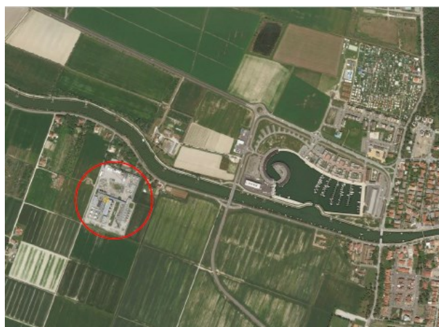
Figura 2.1-8: Esempi di centrale di raccolta di gas naturale di media dimensione in pianura Padana (area ravennate)
