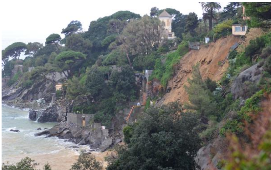
Foto 2.3.1 – Frana in zona Nervi (Comune di Genova), 17-21 gennaio 2014 (Fonte: http://www.ilsecoloxix.it )
