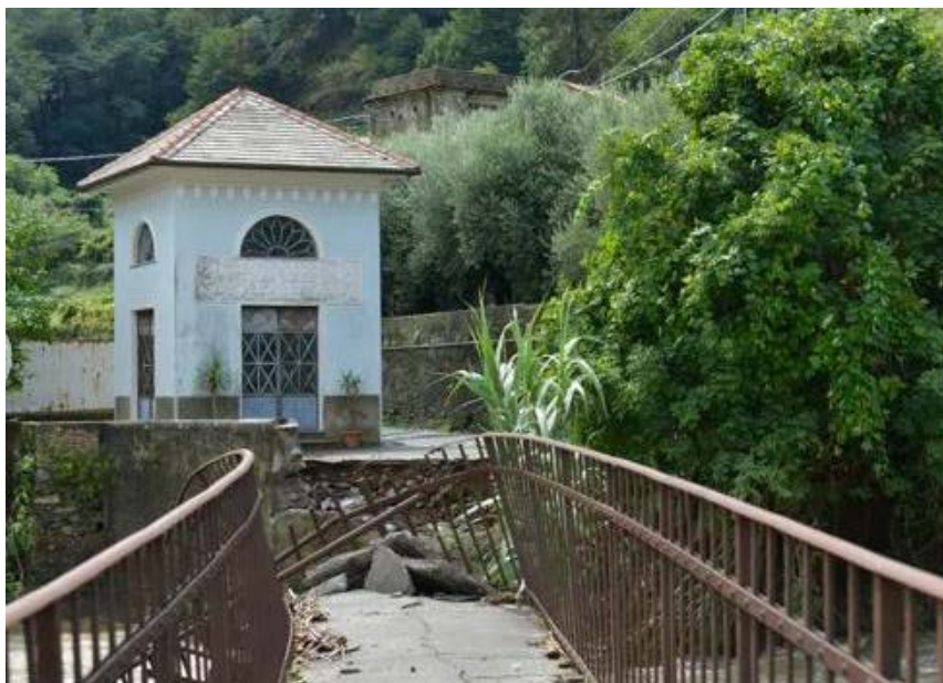
Foto 2.3.2 – Crollo di un ponte pedonale a causa dell'esondazione del torrente Cerusa (Genova Voltri), 19-20 agosto 2014 (Fonte: http://www.ilsecoloxix.it )
