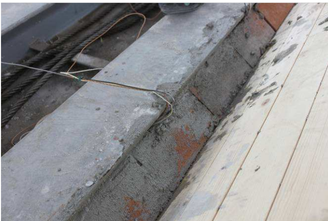
15/5/2015 – figura 32 Posizionamento delle termocoppie interne in corrispondenza della sezione di imposta alle reni
