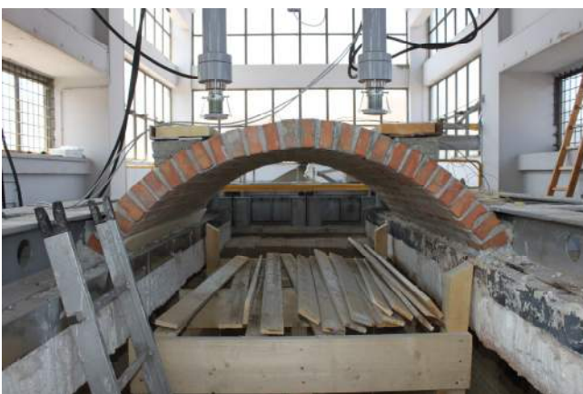
10/6/2015 – figura 52 Vista frontale della volta
