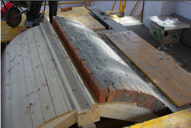
14/5/2015 – figura 30 Completamento della prima metà della volta muraria
