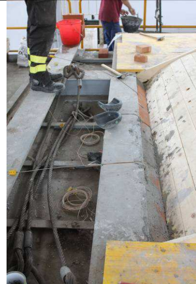
15/5/2015 – figura 33 Posizionamento delle termocoppie interne in corrispondenza della sezione di imposta alle reni
