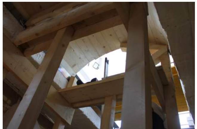
10/6/2015 – figura 47 Inizio rimozione della centina
