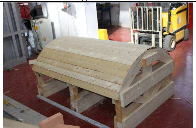
6/5/2015 – figura 17 Completamento del tavolato di appoggio della volta
