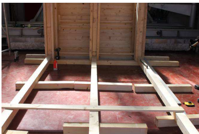
11/5/2015 – figura 18 Inizio realizzazione piedritti centina
