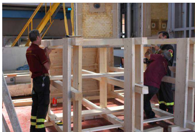
11/5/2015 – figura 19 Fasi di realizzazione piedritti centina
