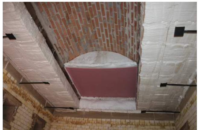
23/6/2015 – figura 59 Completamento della tamponatura del forno orizzontale (riposizionamento delle termocoppie piatte guida forno)
