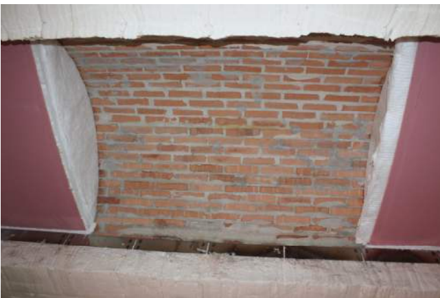
23/6/2015 – figura 58 Completamento della tamponatura del forno orizzontale
