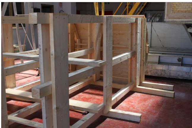
11/5/2015 – figura 20 Completamento realizzazione piedritti centina
