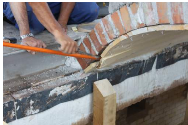
10/6/2015 – figura 49 Rimozione del tavolato
