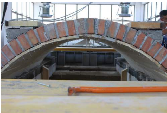
10/6/2015 – figura 48 Rimozione della centina
