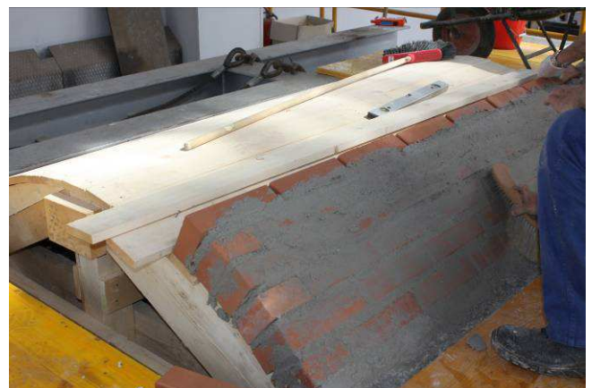
14/5/2015 – figura 29 Prosecuzione della realizzazione della volta muraria
