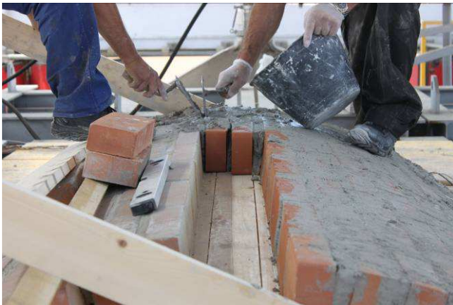
18/5/2015 – figura 36 Chiusura della chiave della volta
