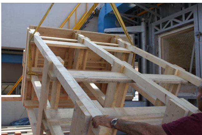
12/5/2015 – figura 22 Issaggio della centina
