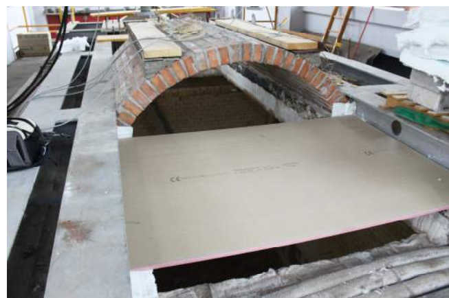
15/6/2015 – figura 53 Inizio tamponatura del forno
