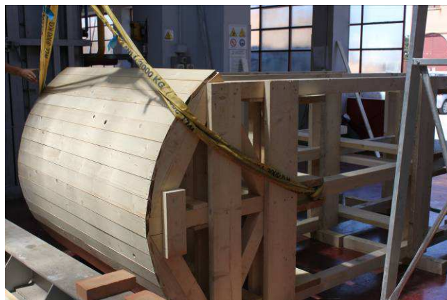
11/5/2015 – figura 21 Imbragatura della centina e collegamento al carroponte
