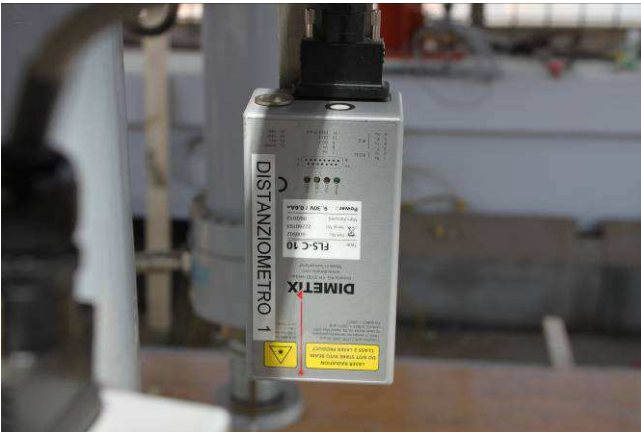
26/5/2015 – figura 44 Posizionamento di uno dei due trasduttori ottici di spostamento, distanziometro (in chiave ed all'appoggio)
