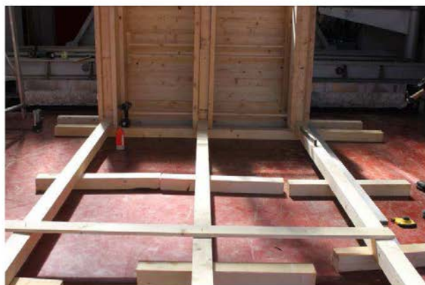
11/5/2015 – figura 18 Inizio realizzazione piedritti cedrina
