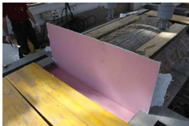
16/6/2015 – figura 55 Tamponatura frontale della volta con lana di roccia e cartongesso
