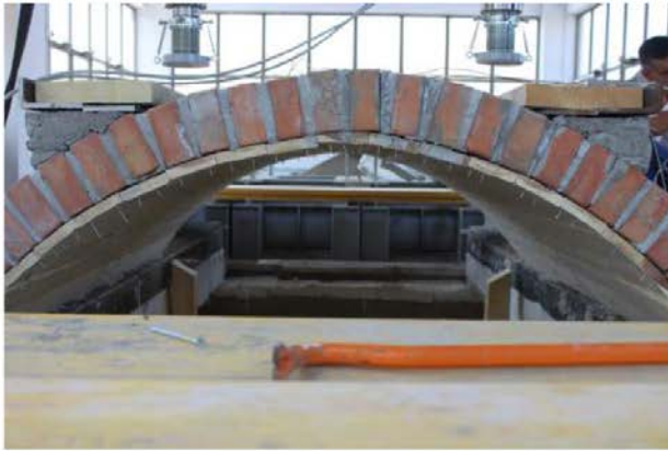
10/6/2015 – figura 48 Rimozione della centina
