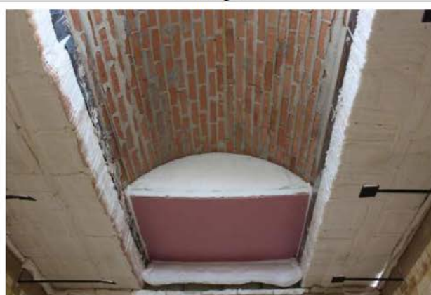
16/6/2015 – figura 57 Tamponatura del forno (vista dall'intradosso della volta. Si noti la stilatura dei giunti di malta)
