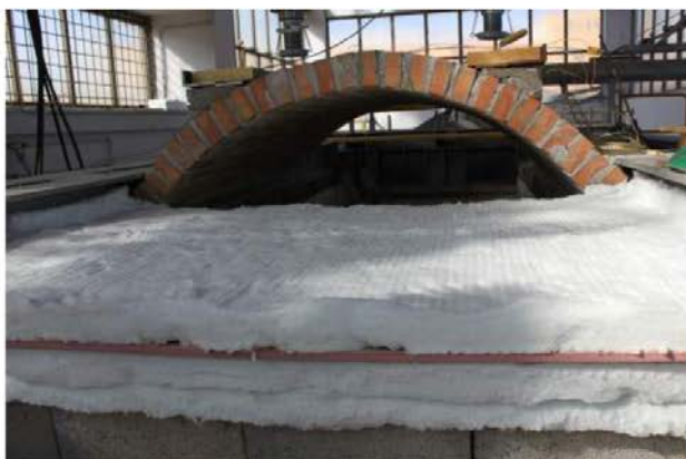
16/6/2015 – figura 54 Esecuzione tamponatura forno con lana di roccia e cartongesso
