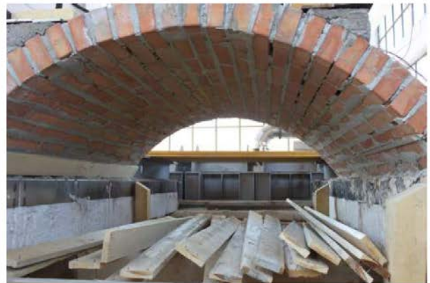
10/6/2015 – figura 51 Vista all'intradosso della volta prima della stilatura dei giunti
