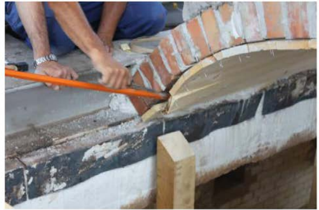
10/6/2015 – figura 49 Rimozione del tavolato
