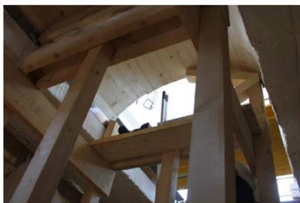
10/6/2015 – figura 47 Inizio rimozione della centina
