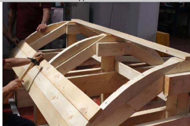
5/5/2015 – figura 16 Predisposizione del tavolato di appoggio della volta
