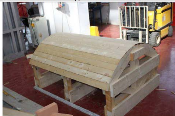
6/5/2015 – figura 17 Completamento del tavolato di appoggio della volta
