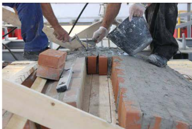
18/5/2015 – figura 36 Chiusura della chiave della volta
