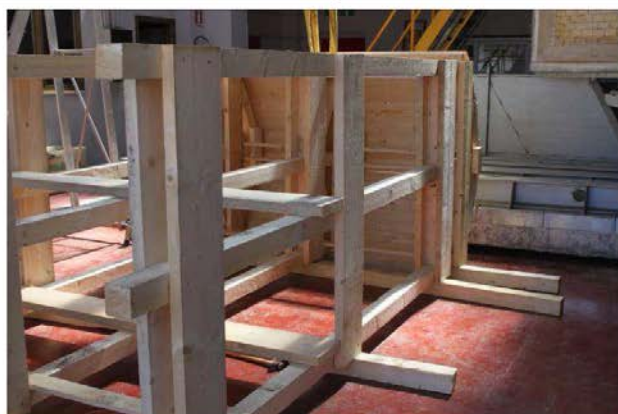
11/5/2015 – figura 20 Completamento realizzazione piedritti cedrina
