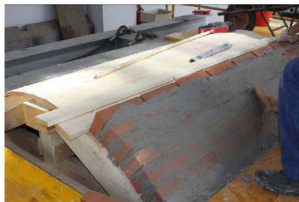
14/5/2015 – figura 29 Prosecuzione della realizzazione della volta muraria
