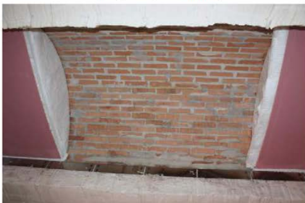
23/6/2015 – figura 58 Completamento della tamponatura del forno orizzontale
