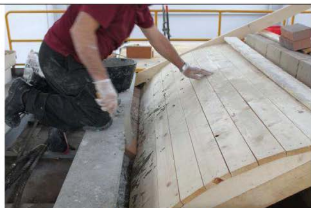
15/5/2015 – figura 31 Inizio della realizzazione della seconda metà volta muraria a partire dalla sezione di imposta alle reni
