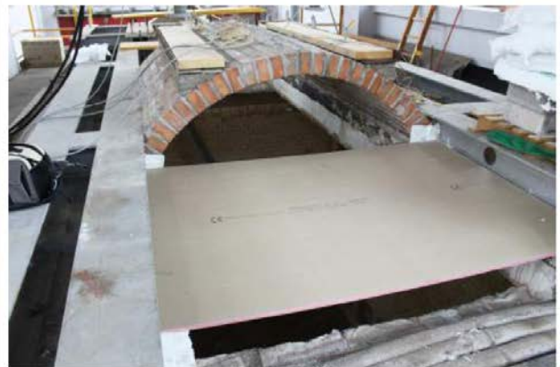
15/6/2015 – figura 53 Inizio tamponatura del forno
