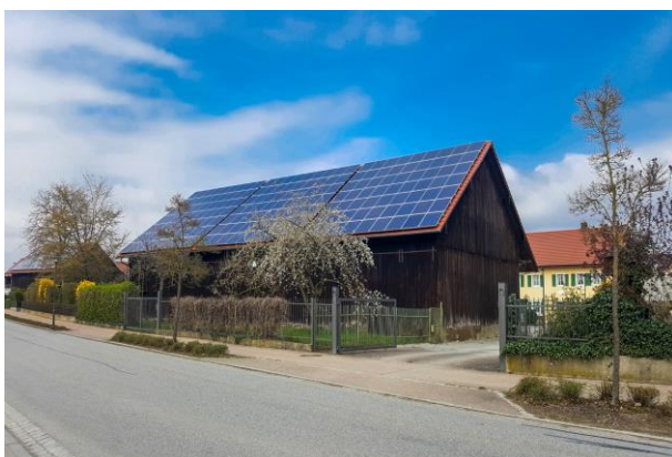
impianto su capannone
