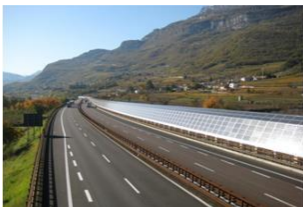
impianto su autostrada (barriera acustica)
