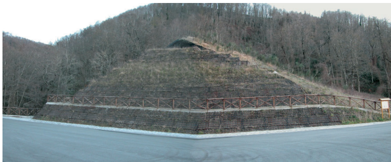
Figura 6.11 - Cava di prestito dopo interventi di ripristino
