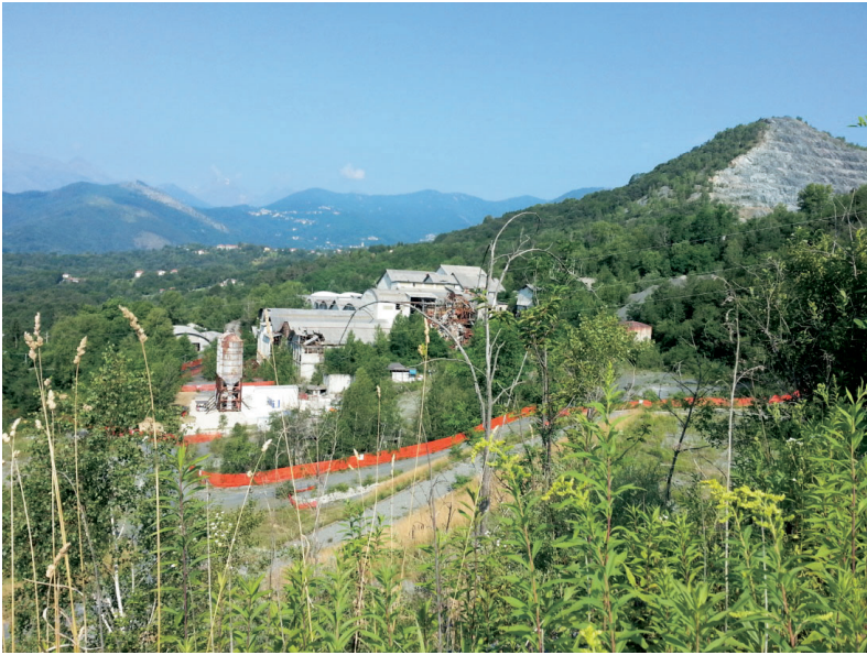
Figura 6.15 - Aree della cava e stabilimenti del SIN di Balangero
