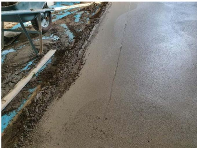
**Fig. 24 – Esempio di realizzazione di un giunto di dilatazione**
