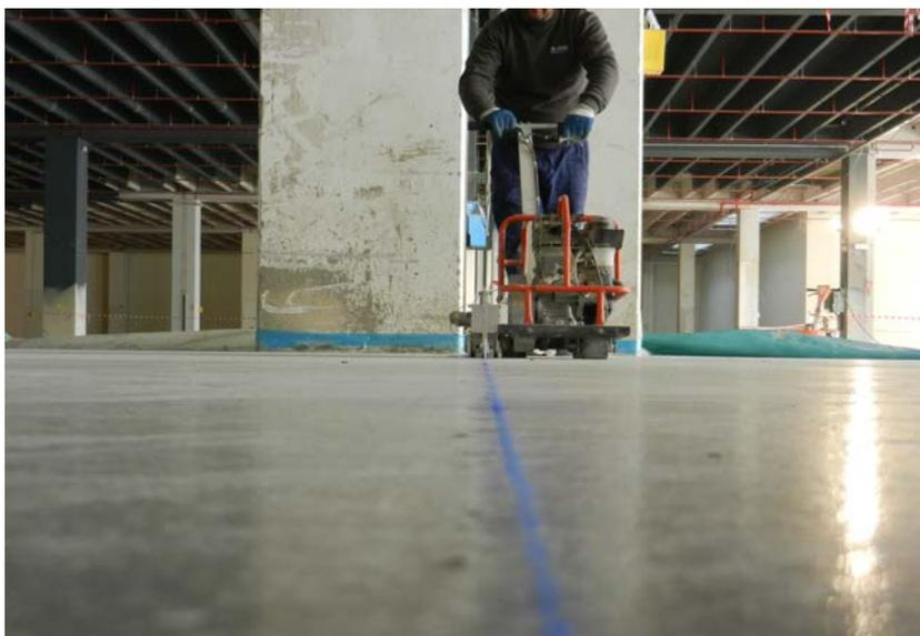
*Fig. 21 – Esecuzione di un giunto di contrazione*
