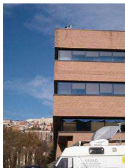
Figura 2.17.2 - La sede centrale dell'ARPAB, in via della Fisica (Fonte: ARPA Basilicata).
