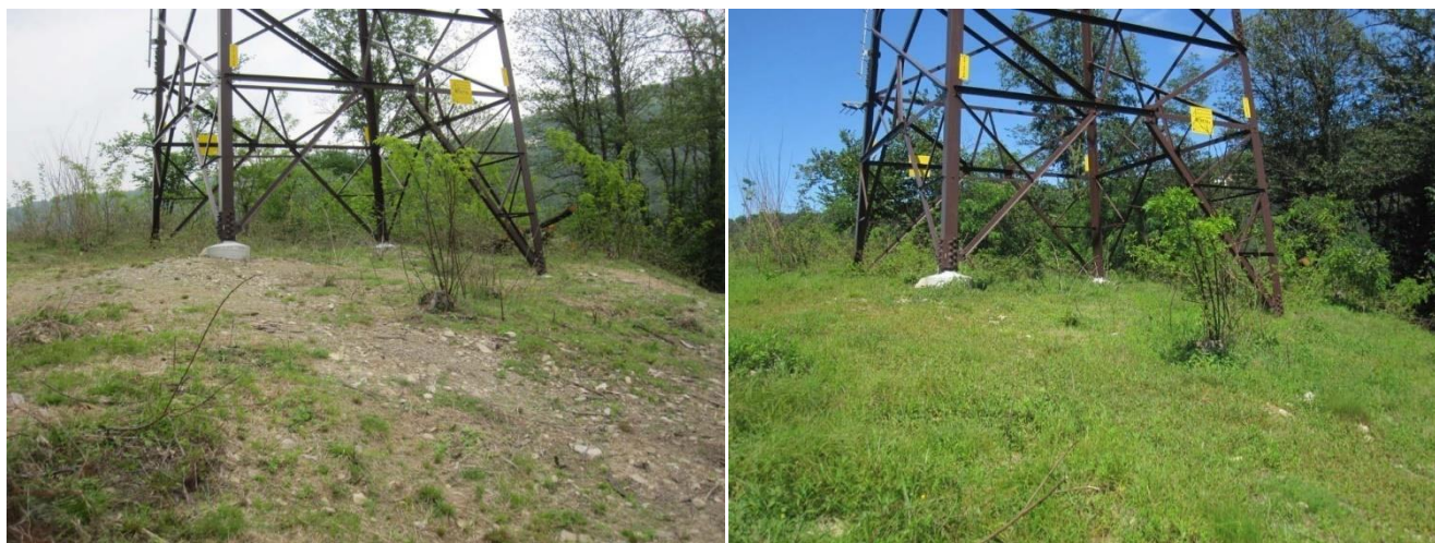
Figura 10-5 Interventi di rinaturazione ante e post operam sulle linee 132 kV della Val D'Ossola Sud
