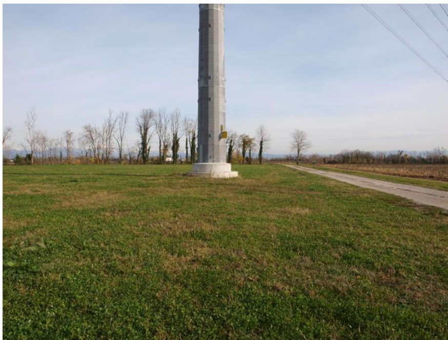
Figura 10-2 Intervento di ripristino ante-operam a prato sulla linea 380 kV Udine Ovest-Udine Sud
