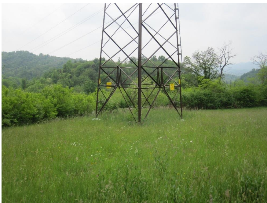
Figura 10-3 Intervento di inerbimento sulle linee 132 kV della Val D'Ossola Sud
