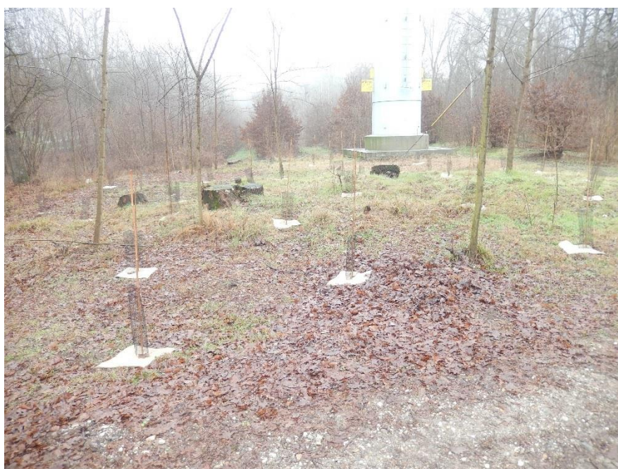
Figura 10-1 Interventi di ripristino nel Parco naturale della valle del Ticino sulla linea 380 kV Trino-Lacchiarella
