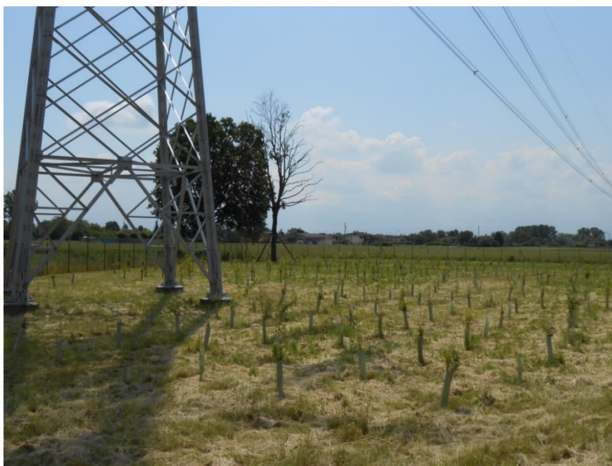
Figura 10-4 Intervento di messa a dimora di alberi e arbusti sulla linea 380 kV Chignolo Po - Maleo
