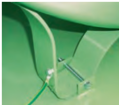
Figura 17: Collegamento a terra del serbatoio
