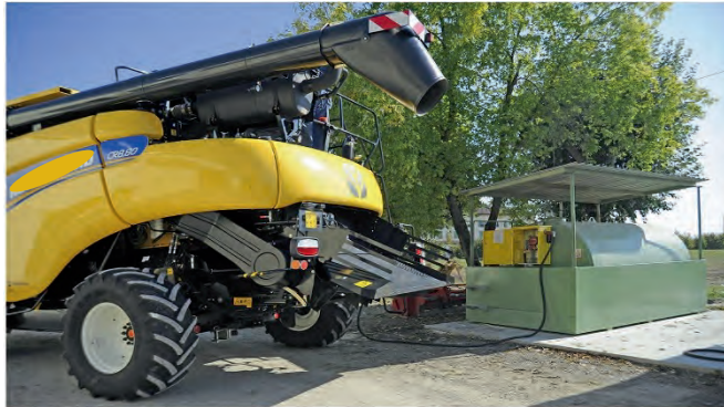
Figura 13: Serbatoio a singola parete con bacino di contenimento
