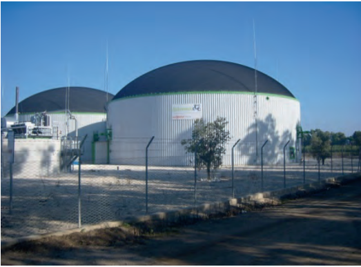
Figura 35: Cupola gasometrica (Fonte: Inail)
