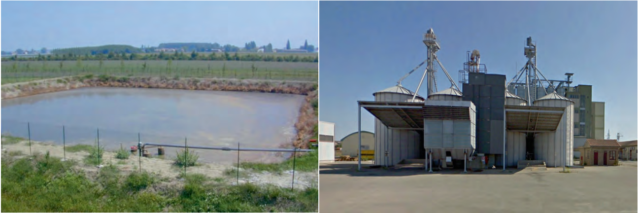
Figure 18 a) e b): esempi di ambiente confinato e/o sospetto di inquinamento; a) vasca di stoccaggio dei liquami; b) silos di stoccaggio (fonte Contarp, Inail)
