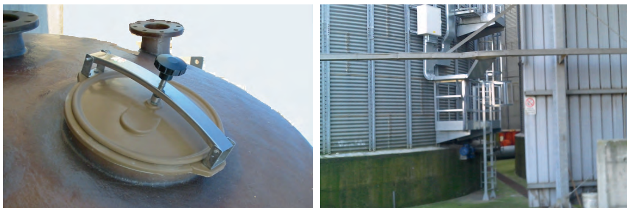
Figura 20 a) e b): esempi non esaustivi di via di ingresso o uscita limitata e/o difficoltosa: a) passo d'uomo su serbatoio, b) scala alla marinara per accesso all'entrata del silos - fonte Contarp, Inail)
