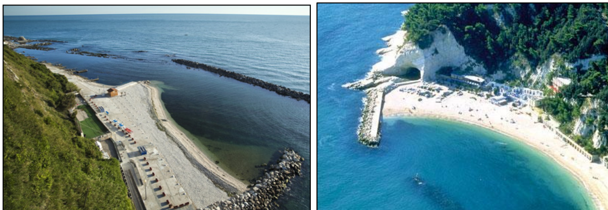
Figura 9.1e 9.2 - Esempi di litorale protetto da opere costiere dove sono stati effettuati i campionamenti (a sinistra Passetto ascensore e a destra Spiaggia Urbani di Sirolo)
