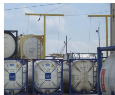
Figure 8.12 - Chandeliers permettant d'arrêter les chutes
