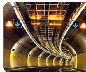
Tipo 1.4016/430, preverniciato, Tunnel Monte Mario, Centro Inox, Italia
