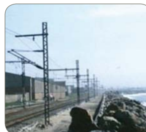
Tipo 1.4003 (la prima più grande applicazione nel 1982, lungo la riva del mare a 10m dalle onde, nessuna corrosione) Sud Africa
