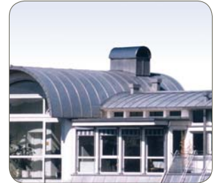
Tipo 430Ti (tecnica standing seam), Ugine e Alz, Austria
