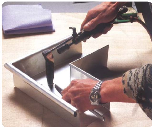
Brasatura dolce di una grondaia, tipo 430Ti rivestito in stagno.
