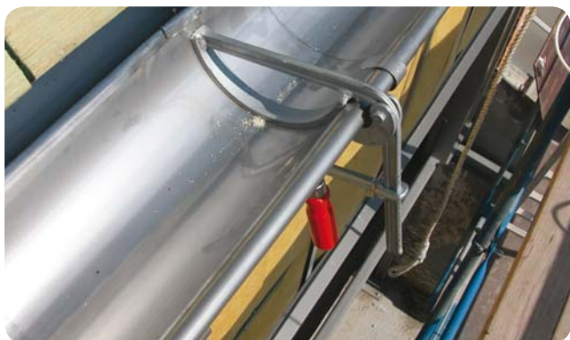
Incollaggio di una grondaia, tipo 430Ti investito in stagno.
