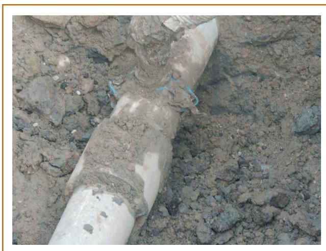
Immagine: Terreno contaminato intorno a tubazione in cemento-amianto ammalorata
