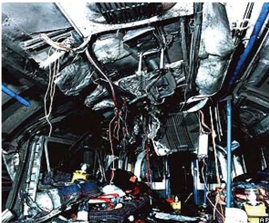
Figura 8. Danni ad una carrozza della metropolitana di Londra prodotti da un ordigno esplosivo improvvisato (IED).
