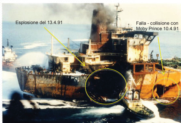
foto n 1: AGIP ABRUZZO: particolare zona collisione ed esplosione
