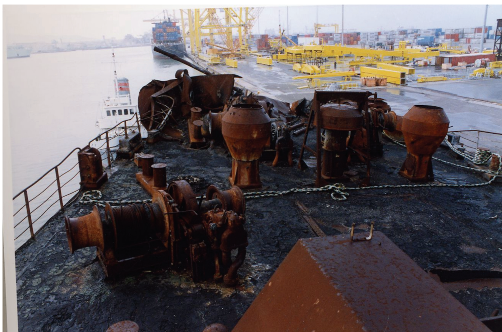
Figura 25. Il Ponte di prua della Moby Prince con i terminali del sistema di areazione del locale elica di manovra.
