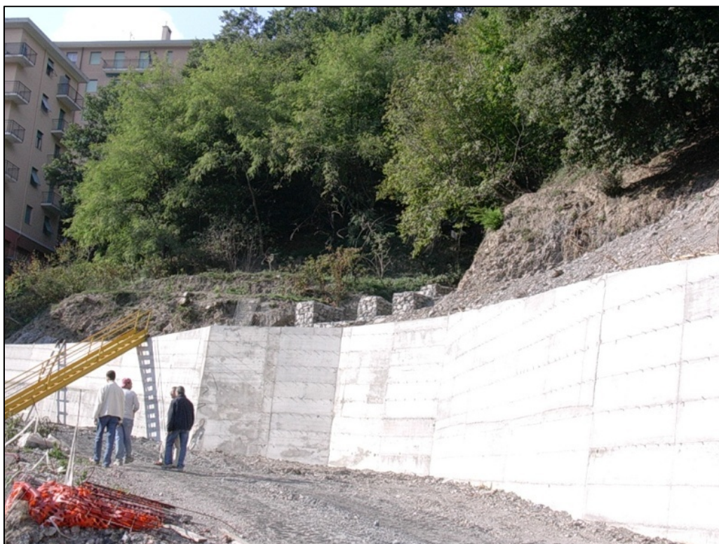
Figura D.7 Muri di sostegno in località Salita Brasile Bolzaneto (intervento cod. ReNDiS 488/02)
