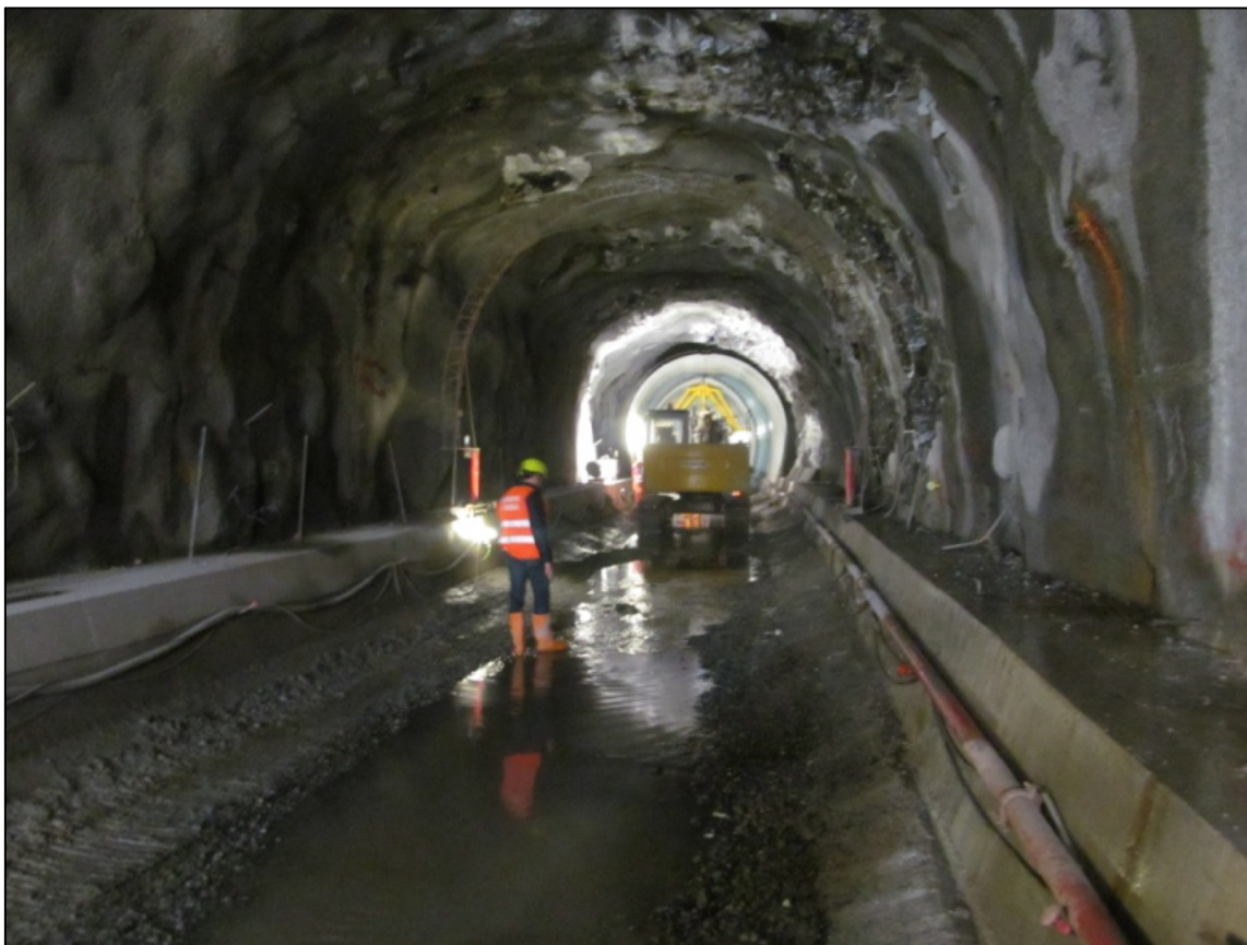
Figura D.9 Lavori nella galleria scolmatore del torrente Fereggiano (intervento cod. ReNDiS 07IR014/G4)
