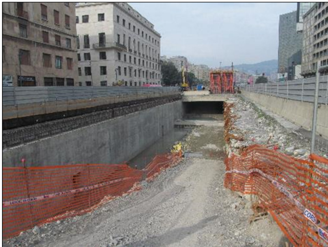
Figura D.10 Lavori relativi all'adeguamento idraulico del tratto terminale del Bisagno (intervento cod. ReNDiS 07IR002/G4)
