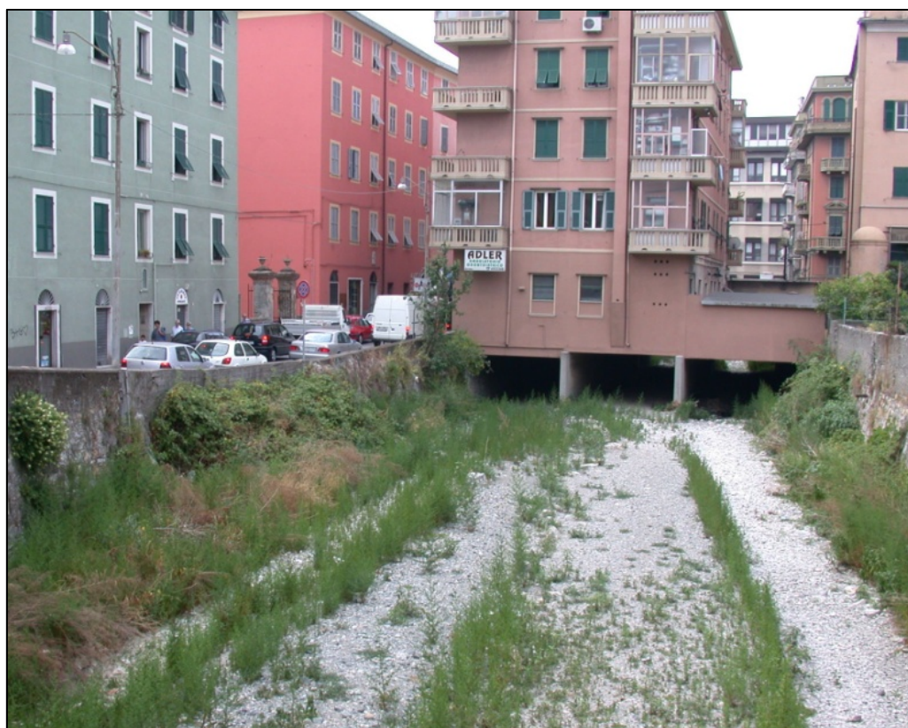
Figura D.8 Torrente Chiaravagna che attraversa Via Giotto (intervento cod. ReNDiS 168/99)
