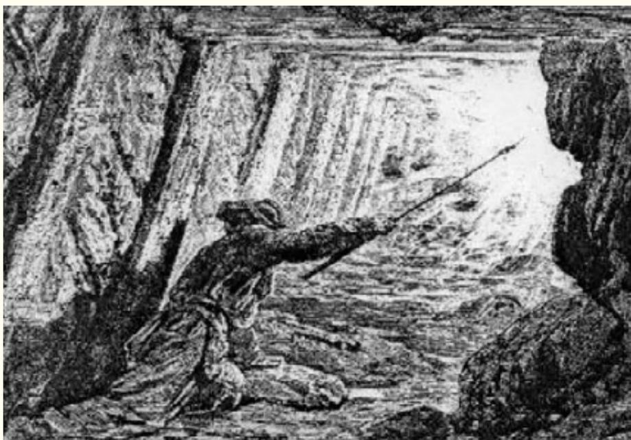
Figura 2: esplosioni controllate per evitare l'accumulo di concentrazioni pericolose di gas in miniera
