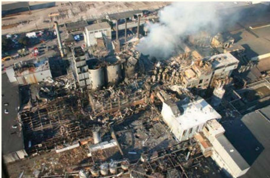
Figura 1: esplosione di una raffineria di zucchero
