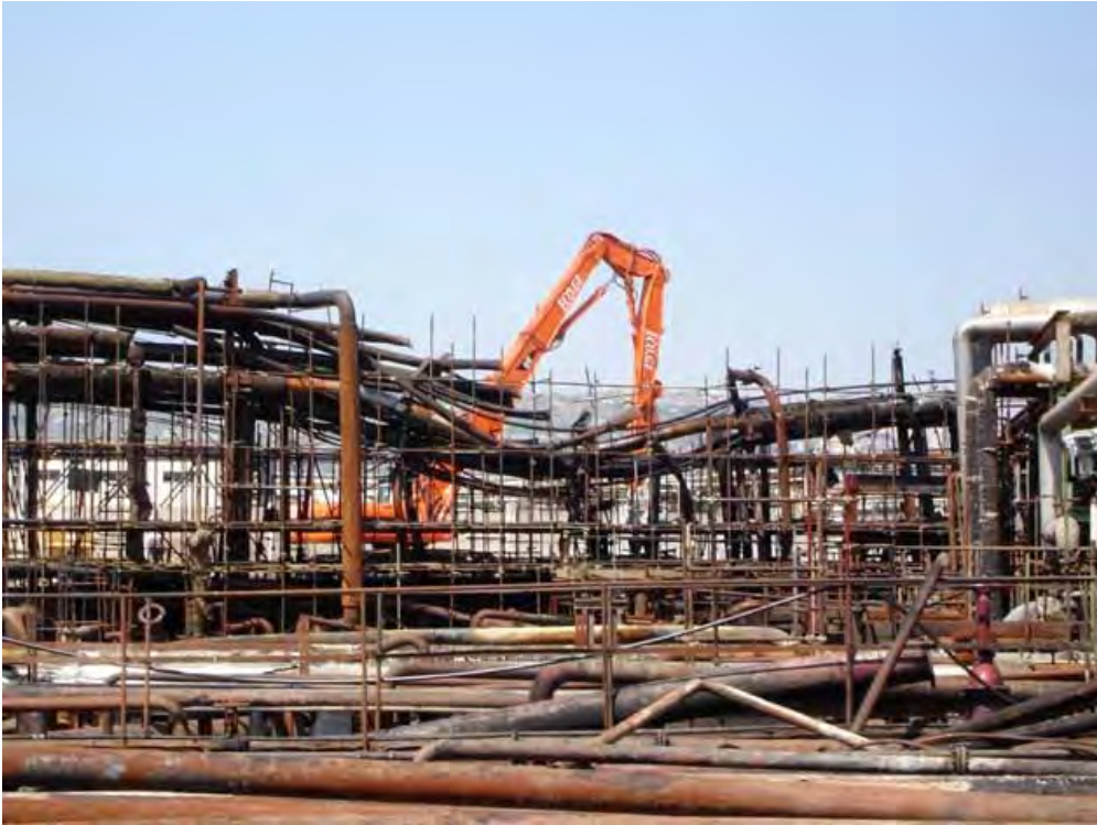
Foto n. 8 – Una fase dei lavori di demolizione delle condotte e delle strutture inutilizzabili
