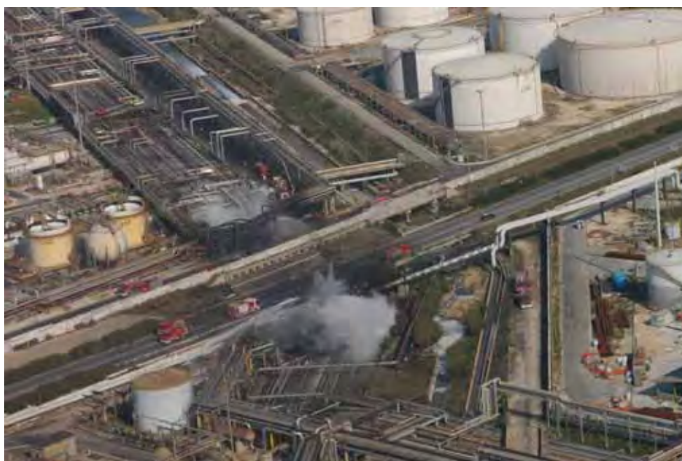
Foto n. 4 : Le operazioni di estinzione viste dall'alto – la ex SS 114 attraversata dalle tubazioni in fiamme e le APS del C.N.VV.F.
