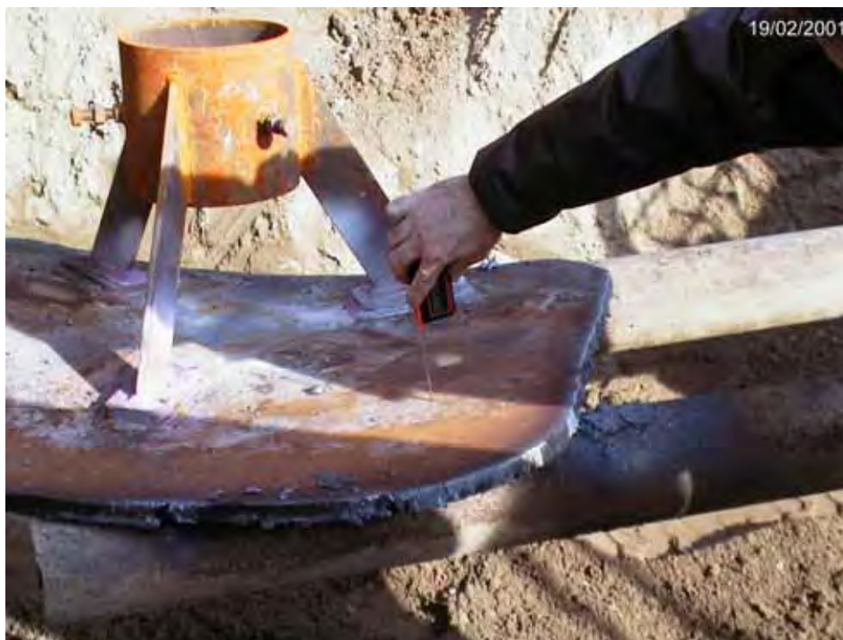
Fotografia n° 6 – Elemento inviato a laboratorio per prove
