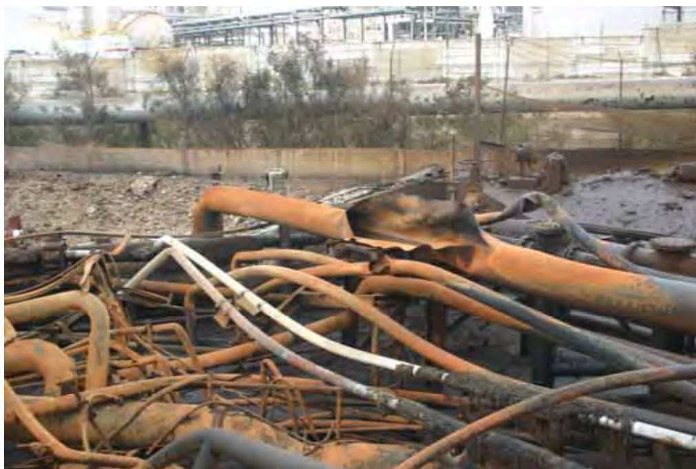
Foto n. 6 : Danneggiamento del fascio tubiero a monte della strada – si notino gli squarci delle tubazioni per B.L.E.V.E.
