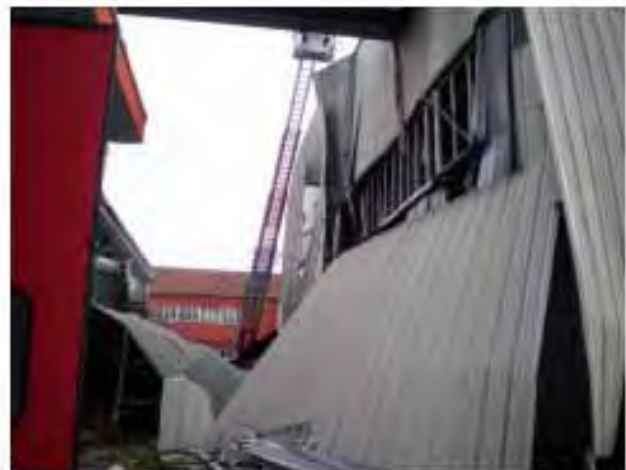
Figura 4. Spostamento lamiere
