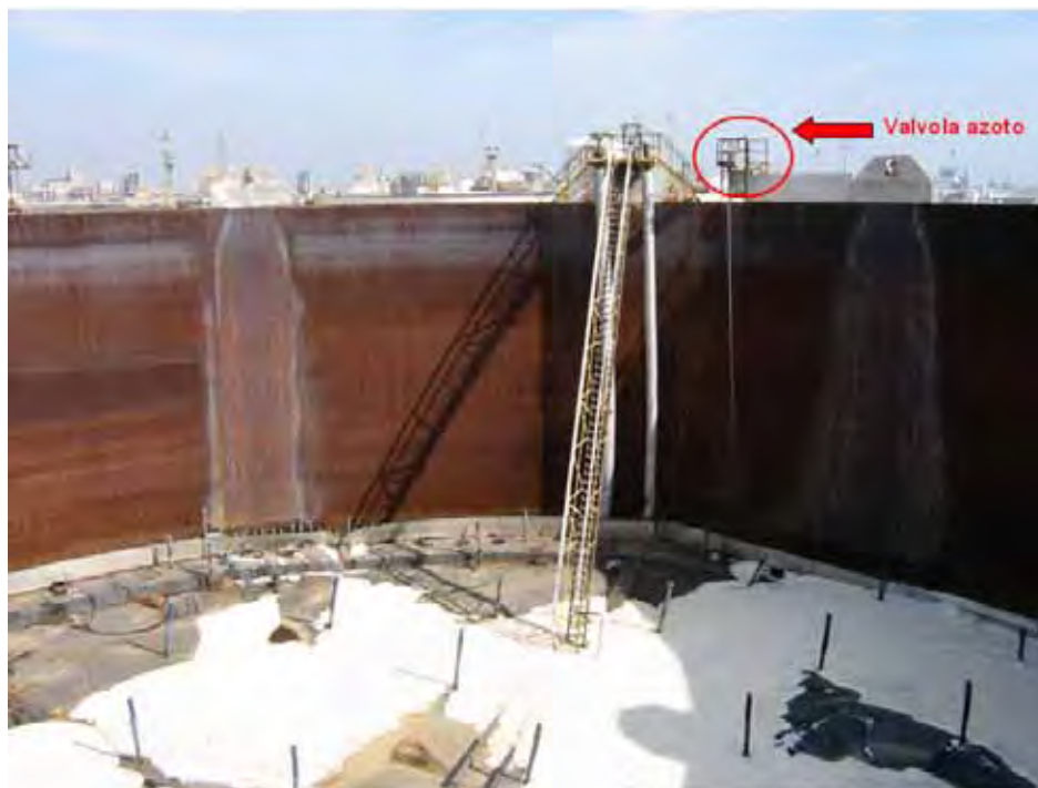
Fig.3 Stato del tetto del serbatoio DA1306
