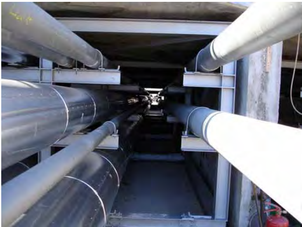
Foto n. 11 – Particolare del cunicolo oleodotti e sua accessibilità dopo i lavori
