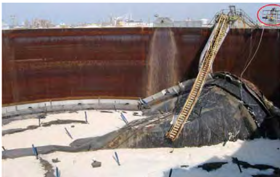
Fig. 2 Stato del tetto del serbatoio DA1305
