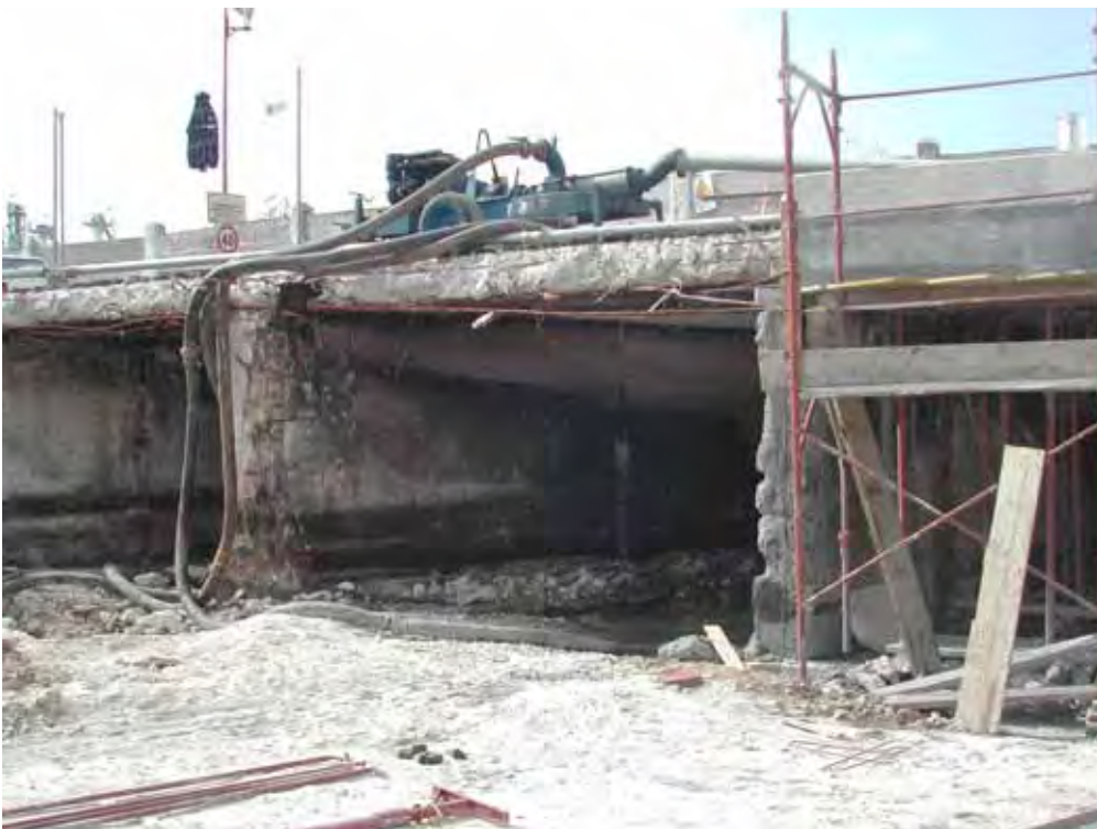
Foto n. 9 – Lavori di ristrutturazione dei cunicoli del sottopasso
