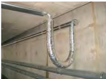
Figura 13 – Curva in una condotta
