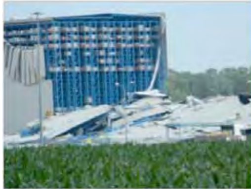
Figure 11, 12. Instabilità delle scaffalature in magazzini intensivi
