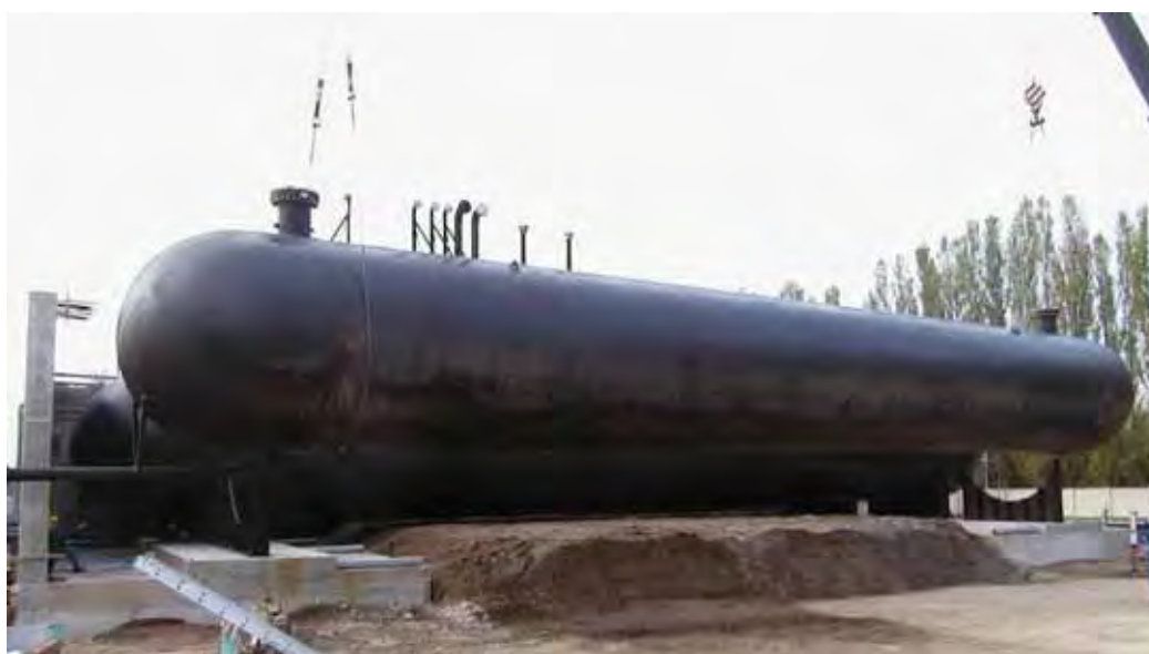
Fotografia n° 1 – Momento posa serbatoio D06
