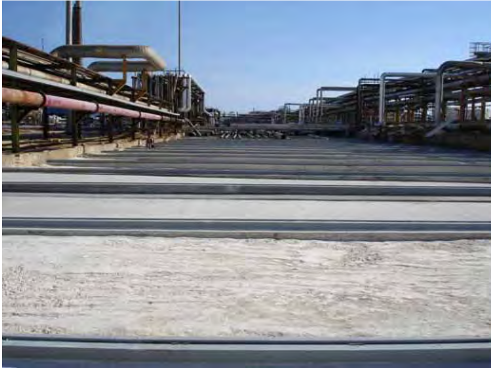
Foto n. 12 – I lavori sul letto di posa delle tubazioni con il particolare delle opere di contenimento e drenaggio
