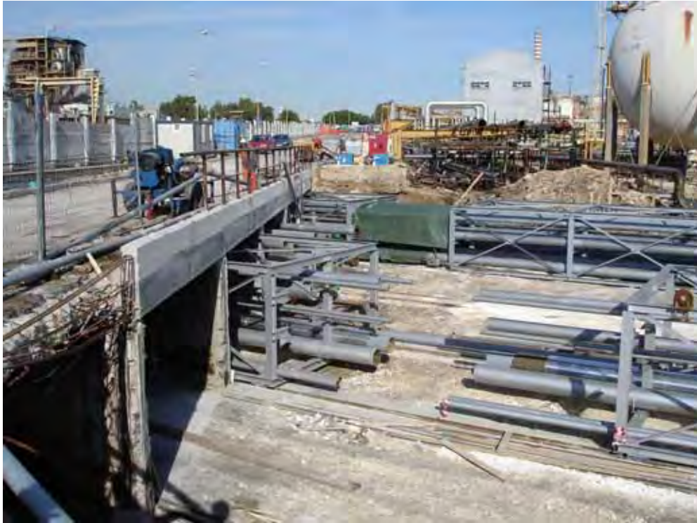
Foto n. 10 – Una fase della posa delle tubazioni con sistemi a rullo
