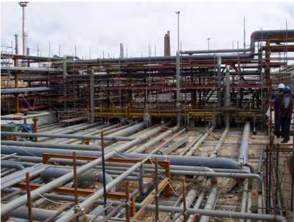
Foto n. 13 – La posa in opera delle tubazioni secondo i nuovi criteri
