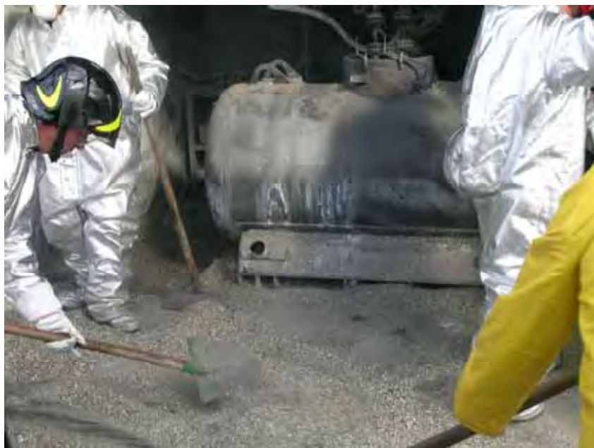
Foto n. 5 – Iniziano le fasi della bonifica con la rimozione del materiale assorbente
