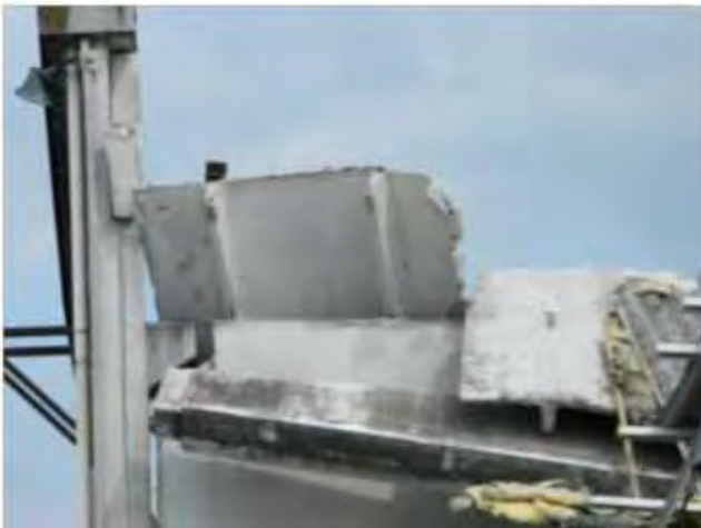
Figure 8, 9 – Caduta laterale della trave
