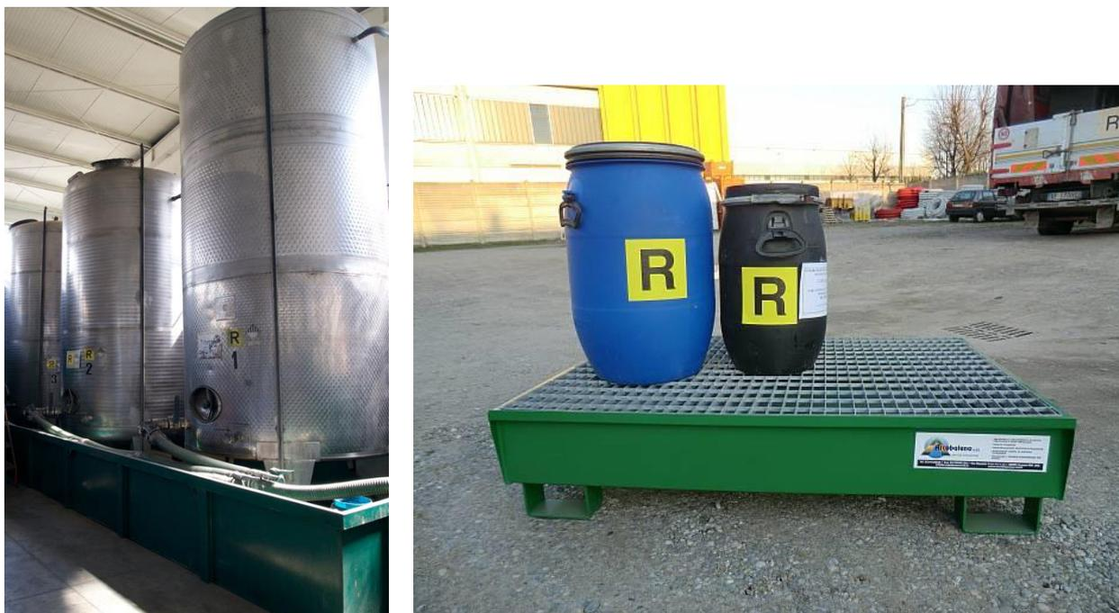
Fig. 10 - Esempi di bacini di contenimento
