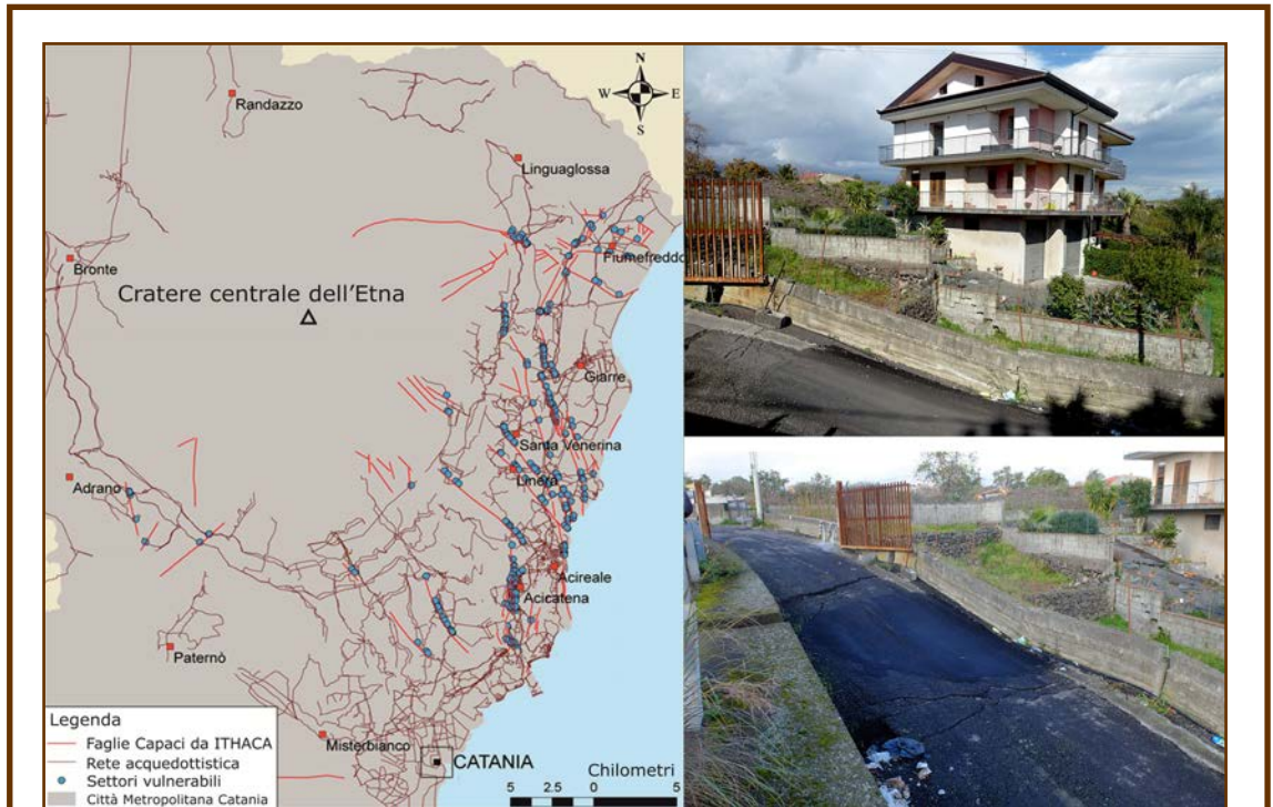
Figura 3 – Sinistra: Distribuzione della rete acquedottistica e delle faglie capaci nell'area etnea della Città metropolitana di Catania. Sono evidenziati i settori vulnerabili per fagliazione superficiale. Fonte: Blumetti et al., 2007. Destra: Abitazione resa inagibile dalla fagliazione superficiale cosismica del terremoto del 26/12/2018. Questa casa è costruita lungo la faglia di Fiandaca. Da notare come la rottura principale sia localizzata circa a metà di un pendio (si tratta di una cosiddetta "scarpata di faglia") che è l'espressione morfologica della faglia capace, censita e mappata con molta precisione dal Database ITHACA di ISPRA. A seguito dell'evento, l'abitazione, oltre ad essere stata attraversata dalle fratture visibili in foto, si è inclinata di alcuni gradi, cosa che non può essere recuperata da alcun intervento edilizio. Fonte: ISPRA.
