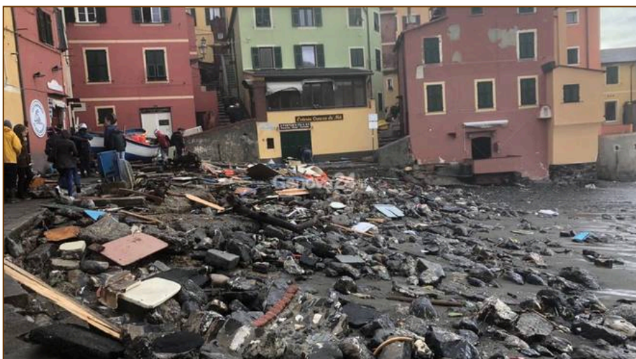
Foto 8: Genova, 29 ottobre 2018. Fenomeni erosivi e lesionamento delle strutture antropiche causati dalla mareggiata del 28 e del 29 ottobre a Boccadasse.
