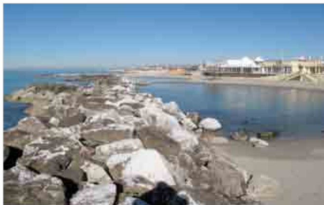
Foto 11: zona di ristagno, in cui si deposita limo.
