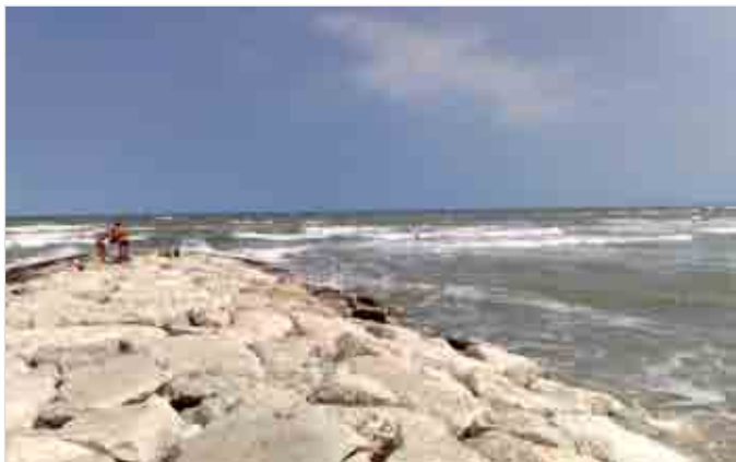
Foto 6: effetto di riempifondo creato da un pennello (foto Sezione di Ravenna).
