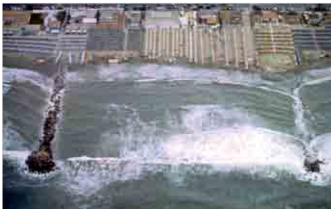
Foto 17: vasca semiaperta, chiusa da una barriera suffolta, a Marina di Massa (foto Domenico Scala).
