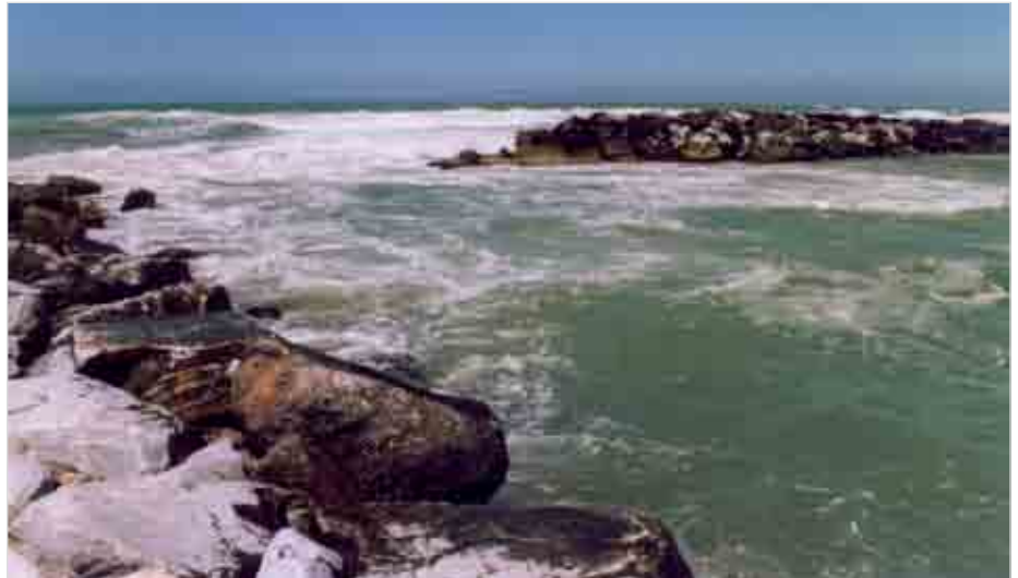
Foto 21: la corrente esce dal varco come un fiume in piena.
