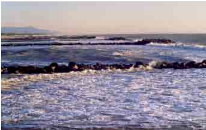
Foto 15: serie di pennelli chiusi da barriere soffolte.
