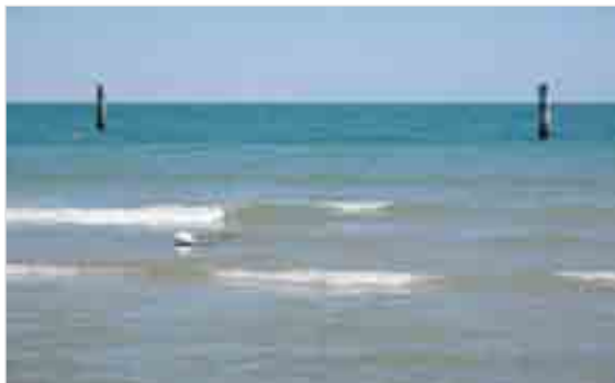
Foto 10: barriera suffolta, cioè sommersa, appena affiorante in superficie; è indicata dalle torri.
