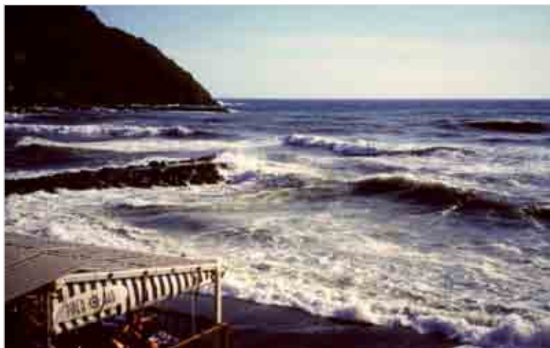
Foto 5: intercettazione della corrente litorale da parte di un pennello (Levanto, SP).
