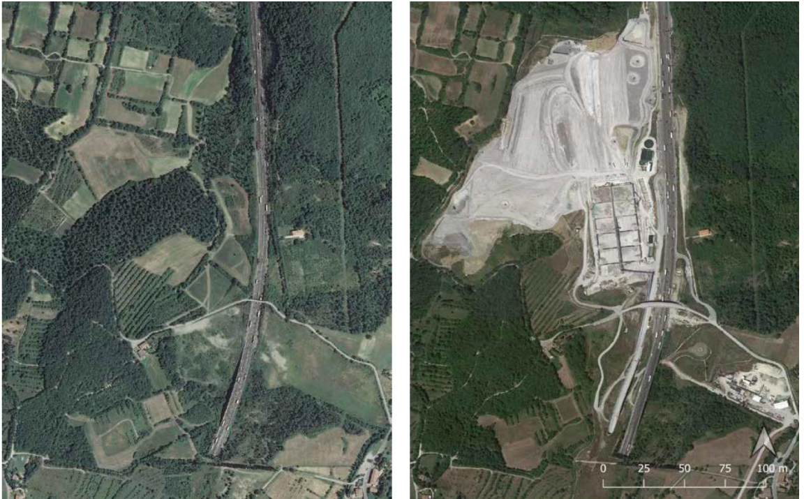
Figura 1. Un esempio di consumo di suolo a Barberino del Mugello (Firenze) per la realizzazione di una nuova area di servizio autostradale, che rende evidente come le nuove infrastrutture possano impattare sul territorio anche a causa delle attività ad esse collegate. A sinistra l'immagine satellitare dell'area prima dell'inizio dei lavori, a destra la stessa area nel 2019
