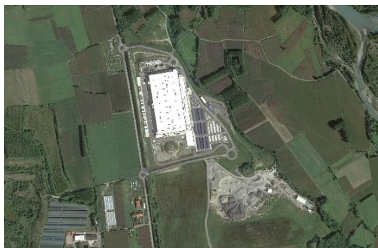
Figura 33. Le aree di cantiere per i lavori del polo logistico nel comune di Torrazza Piemonte (Torino), parzialmente ripristinate nel 2019
