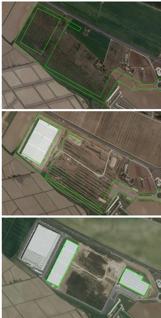
Figura 3. Costruzione di magazzini e uffici per la sede italiana di una catena di supermercati tedesca in una nuova area industriale di più di 36 ettari totali di cantiere (di cui 25 impermeabilizzati) a Oppeano (VR); il primo magazzino di circa 61.400 m 2 , costruito nel 2018, gli altri due, rispettivamente di 41.500 e 29.000 m 2 costruiti nel 2019 e opere viarie e parcheggi per 113.000 m 2 . Immagine 2015 in alto, 2018 in mezzo; 2019 in basso.
