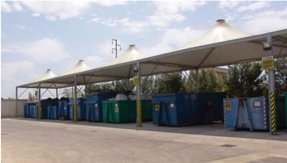
Fig. 16 - Area deposito temporaneo con tettoia
