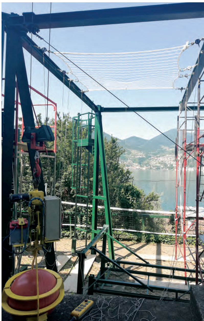
Figura 4.2.2.5-3 - Approntamento della prova
