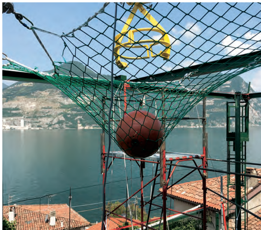
Figura 4.4.3.-6 - Deformazione finale della rete - 8 ancoraggi. Rete 2x4 (m), maglia 100x100 (mm), h = 2 m
