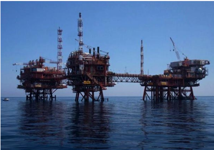
Foto 3.1. Impianti di estrazione in mare Adriatico.
