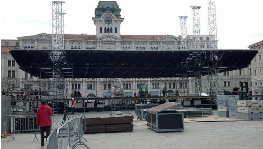
*Figura 22 - Esempio di Ground support*
