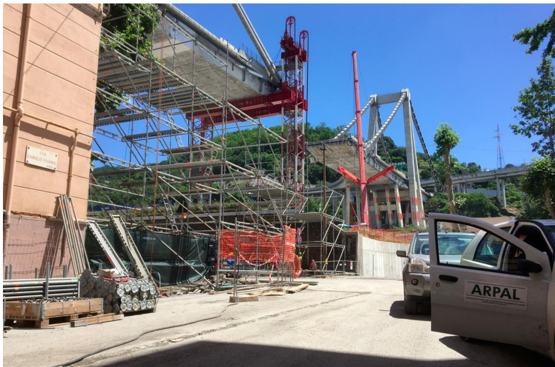
Figura 1: Sopralluogo ARPAL presso il cantiere della demolizione
