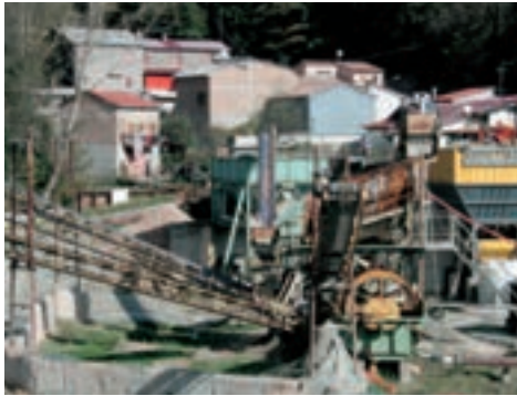
Figura 36 Panoramica dell'impianto per le lavorazioni di inerti
