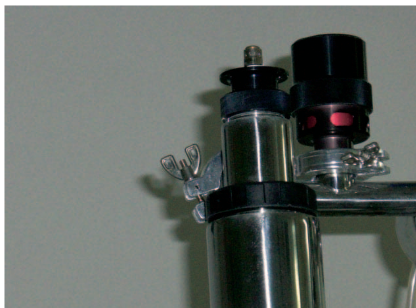
Figura 7 Valvola a tappo tarata ad un valore massimo di pressione interna che, in caso di surriscaldamento del magnete, si apre liberando l'elio nell'ambiente
