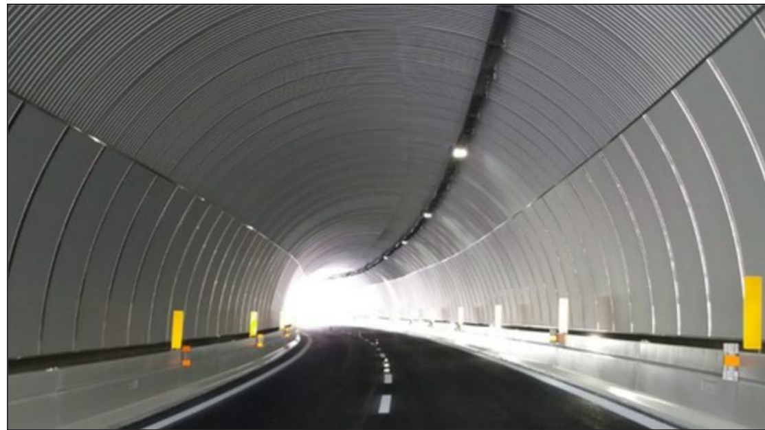
Figura 1. Rivestimento concluse le lavorazioni
