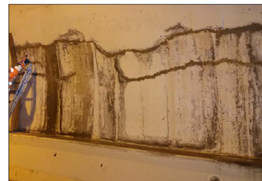
Danno B1 - Iniezione delle fessure
