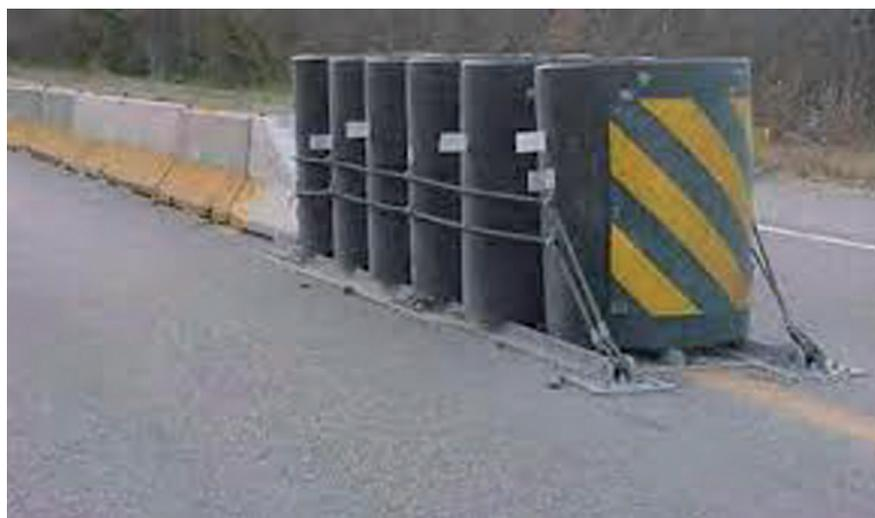
**Figura 8-10:** *Attenuatore d'urto di tipo inerziale*
