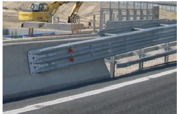
**Figura 8-15:** *transizione tra barriere dello stesso materiale e in materiali differenti*
