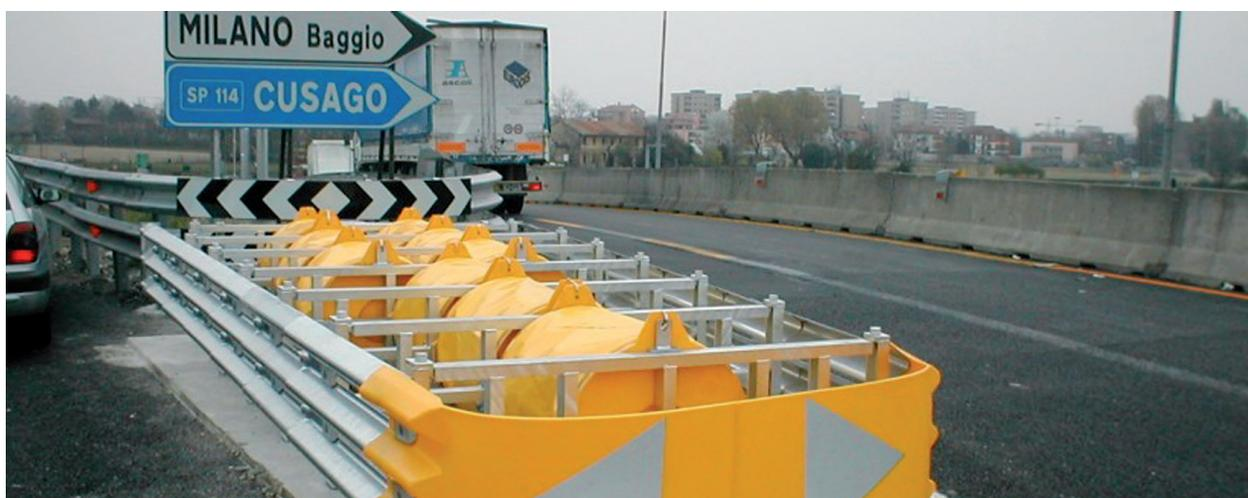
**Figura 8-9:** Attenuatore d'urto di tipo cinetico
