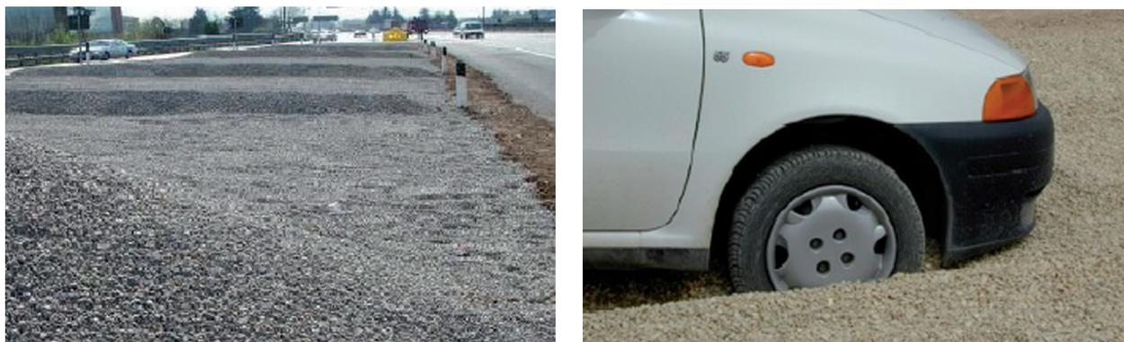
Figura 8-13: Particolari del letto di arresto
