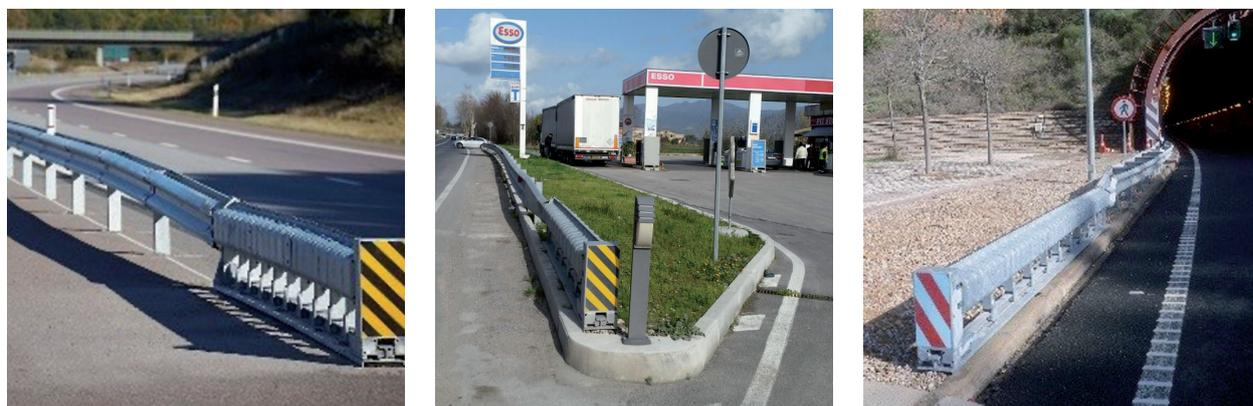
**Figura 8-6:** esempi di installazioni di terminali speciali
