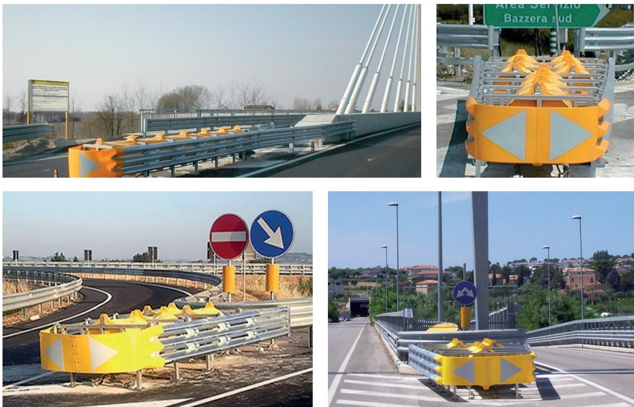
Figura 8-8: Esempi di installazioni di attenuatori d'urto
