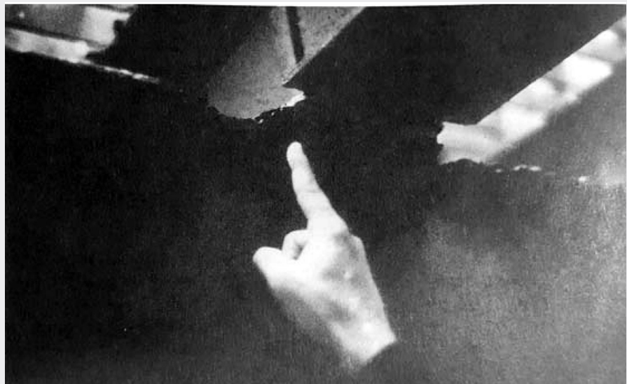
Figura 13. Esempio di danneggiamento per presenza di ruggine [2].
