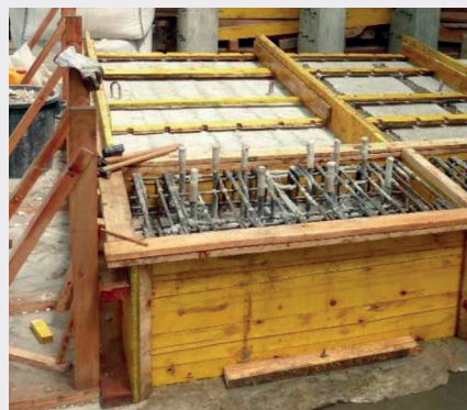
Figura 36. a) Cassaforma per getto cordolo; b) Elemento completo.
