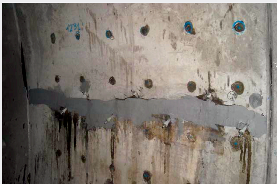
Fig. 7. Iniezione della fessura
