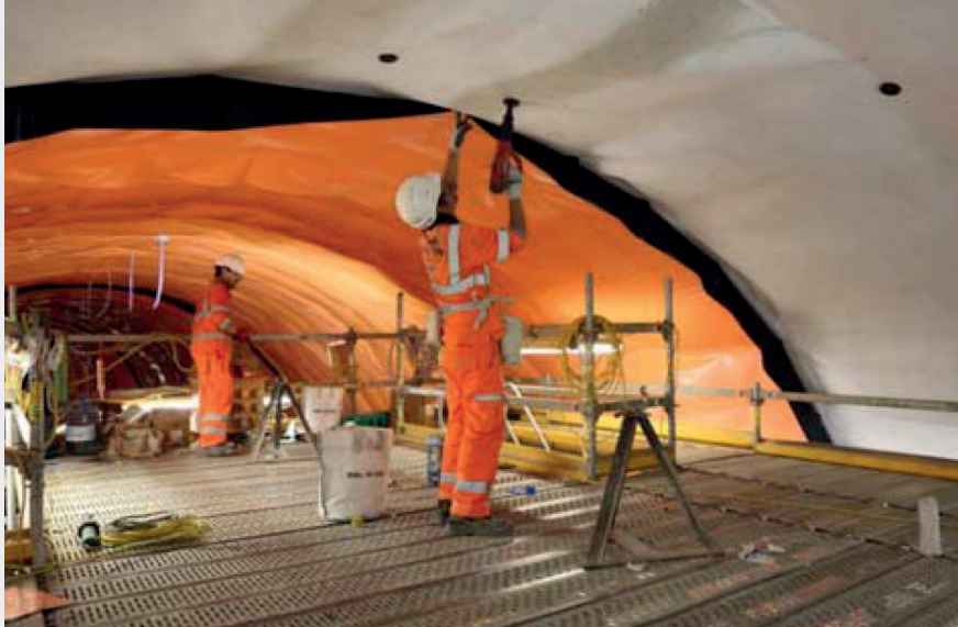
Fig. 4. Installazione dei dischi di fissaggio.
