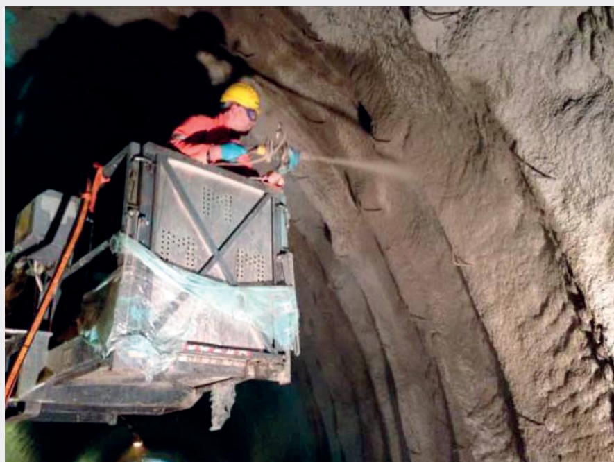
Fig. 21. Esecuzione dello strato di regolarizzazione con calcestruzzo proiettato.
