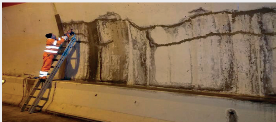
Fig. 9. Iniezione della fessura
