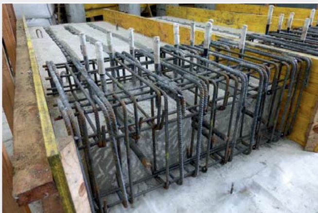
Figura 23. Porzione soletta esistente in c.a. con armatura cordolo ed armatura di rinforzo.
