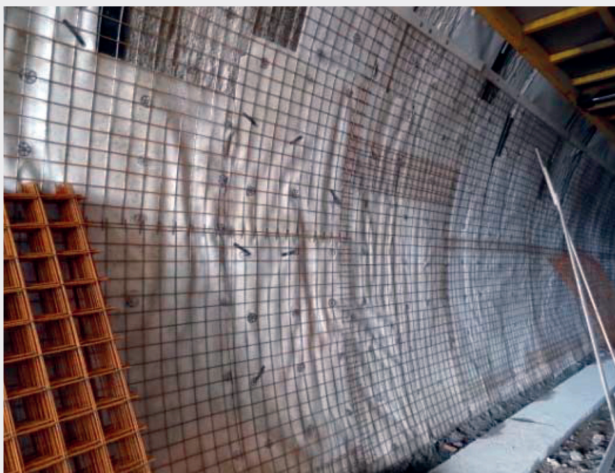
Fig. 15 Fissaggio della rete di armatura.
