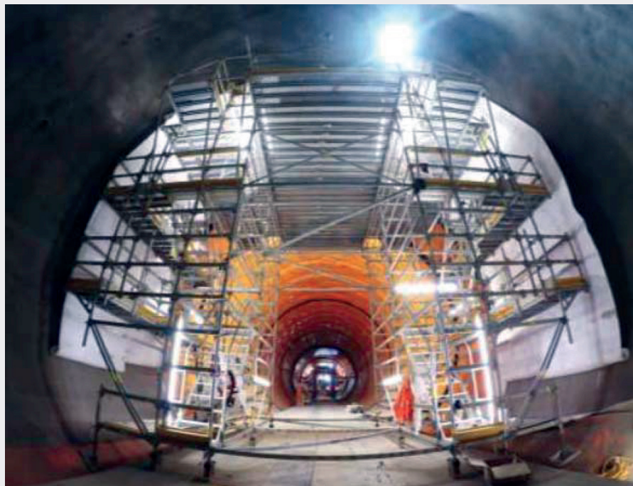
Fig. 3. Posa dello strato in tessuto non tessuto.
