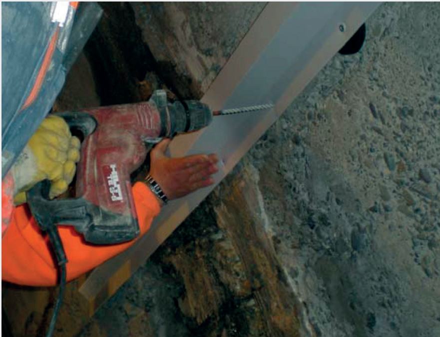
Fig. 12 Fissaggio della scossalina superiore.
