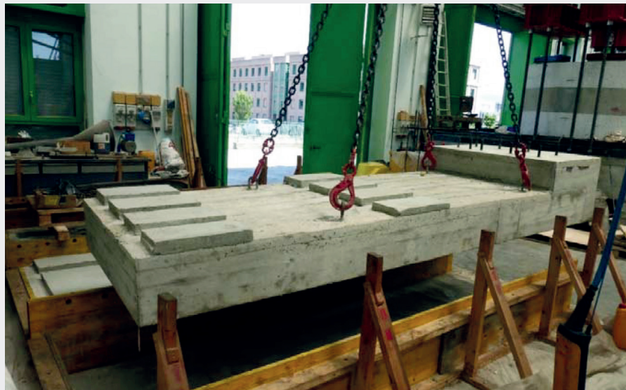
Figura 30. Porzione di soletta in c.a. con cordolo bordo ponte di estremità.
