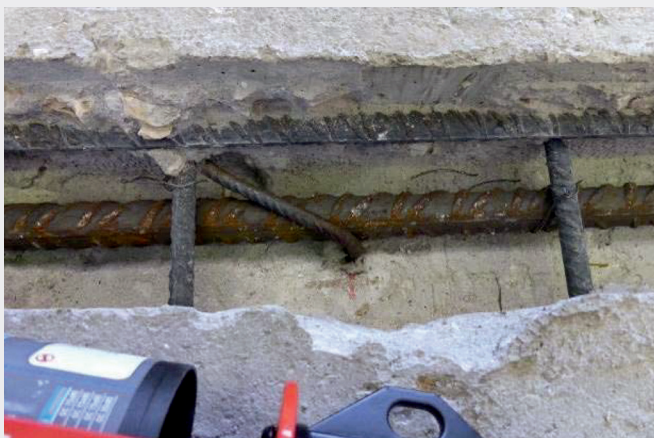
Figura 24. Dettaglio barre di rinforzo.
