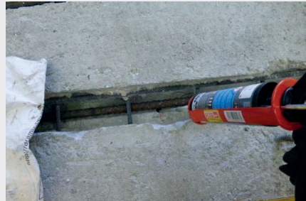
Figura 34. Dettagli posizionamento barra di rinforzo in acciaio.
