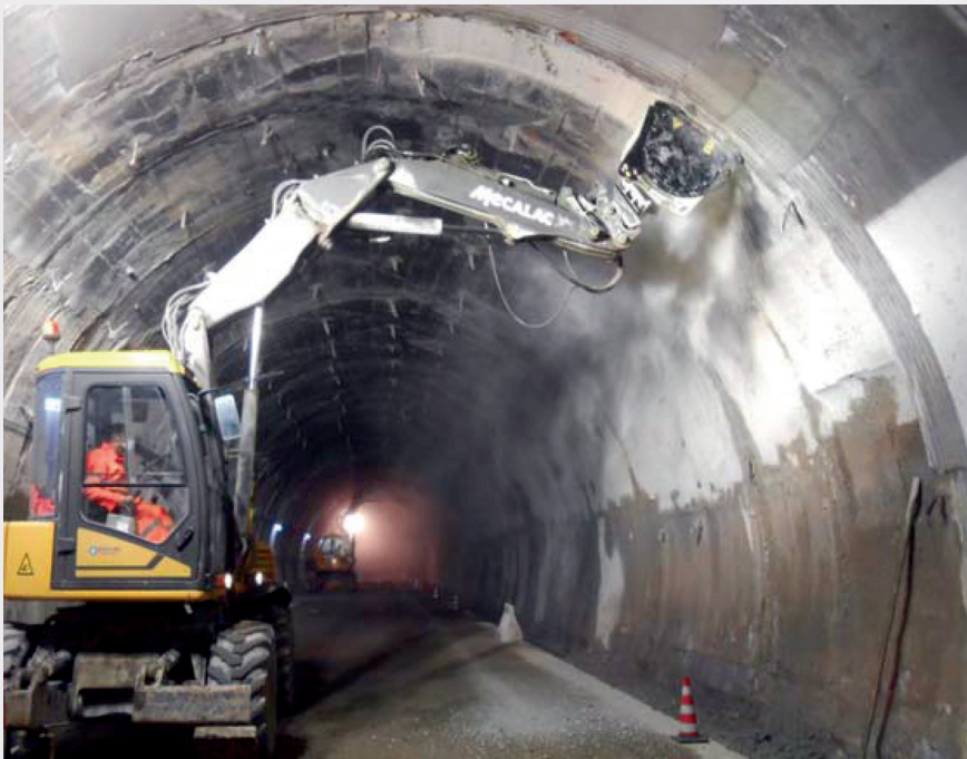
Fig. 11 Preparazione del supporto: idrodemolizione.
