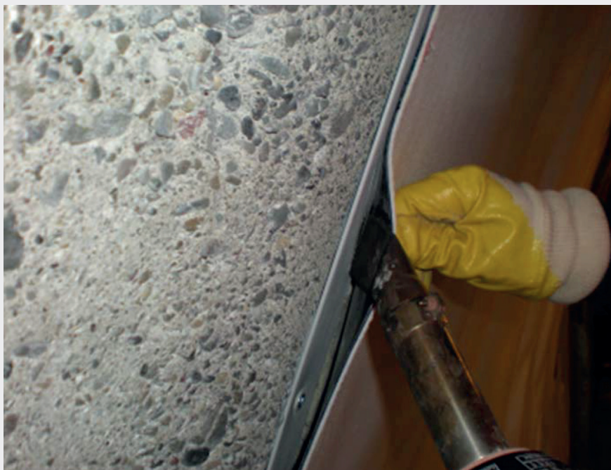
Fig. 14 Saldatura del telo al profilo laterale.
