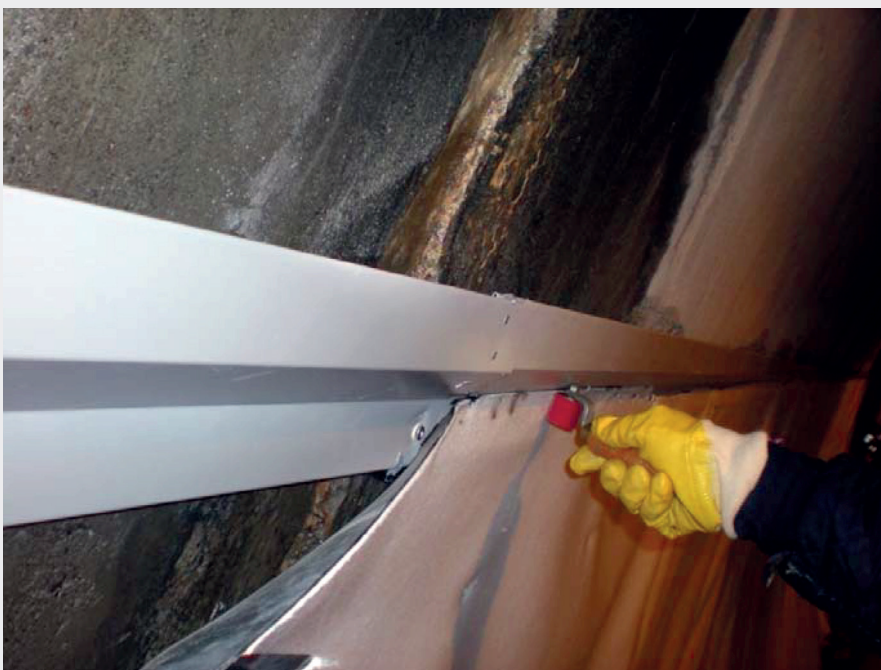
Fig. 13 Accoppiamento con il telo in TPO.
