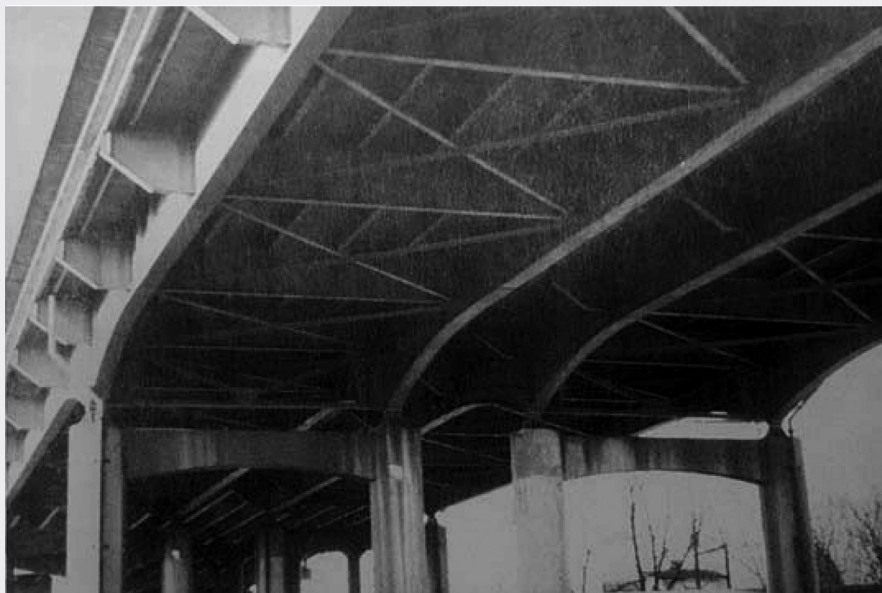
Figura 11. Esempio di impalcato in buone condizioni [2].
