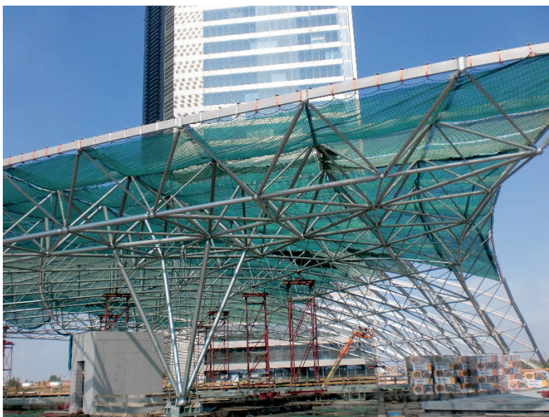
Figura 5.2.1-2 Esempio di sistema S: copertura in acciaio
