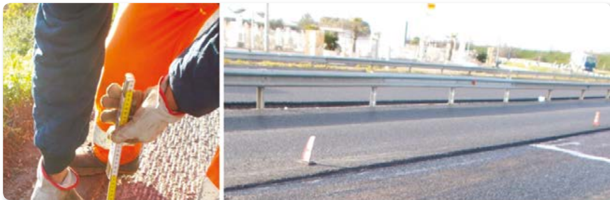
Figura 5.24. Esempio di superficie fresata
