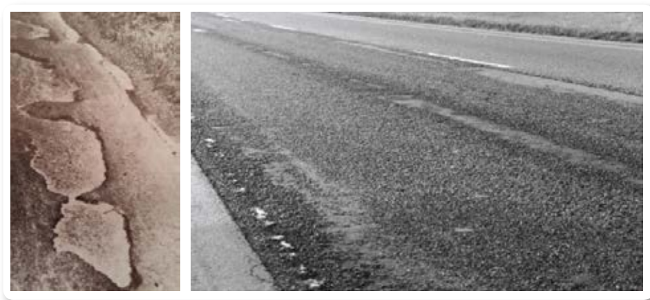
Figura 6.8. Pelature (sx) e sgranamenti (dx)
