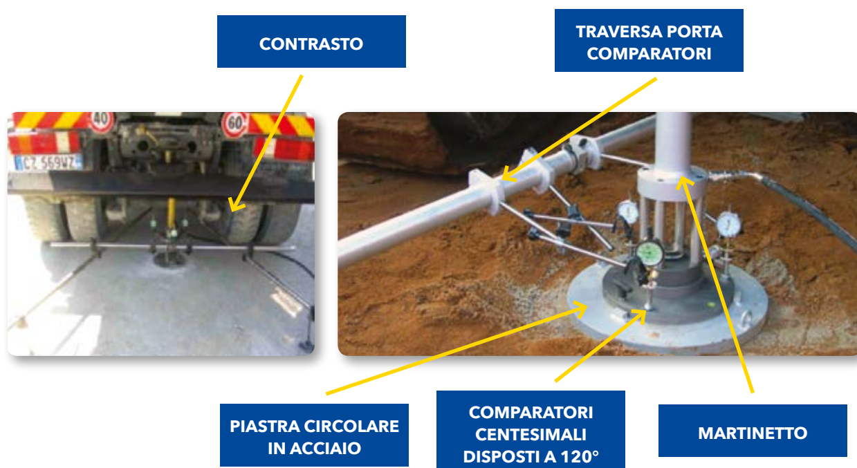
Figura 3.16. Prova di carico su piastra
