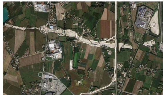
Figura 77. Cantieri stradali per la Pedemontana Veneta tra i comuni di Spresiano e Villorba (TV)
