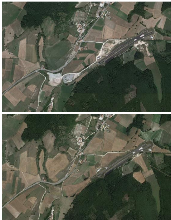
Figura 24. Nell'immagine sopra (2016) sono visibili le aree di cantiere per i lavori sulla strada statale 77 della Val di Chienti, a Foligno. Sotto la stessa area ripristinata nel 2018
