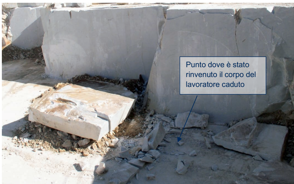
Foto 3 - ubicazione del corpo del lavoratore caduto
