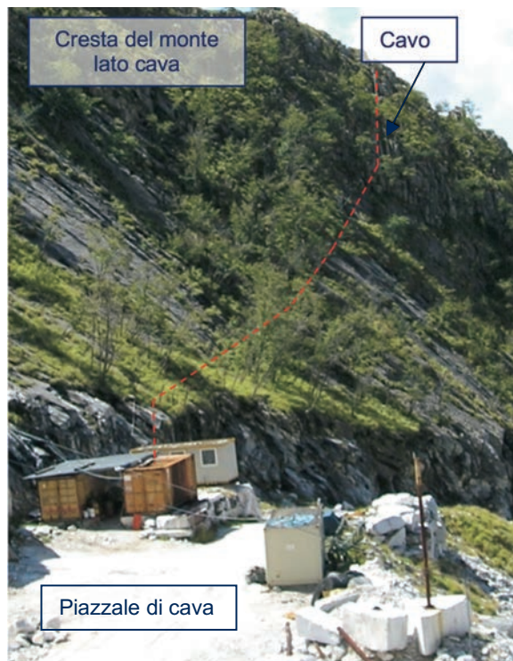
Foto 5 - in rosso rappresentazione grafica della stesura del cavo elettrico
