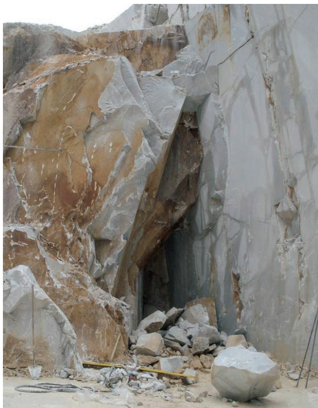
Foto 1 rappresentativa del luogo di lavoro dopo l'incidento
