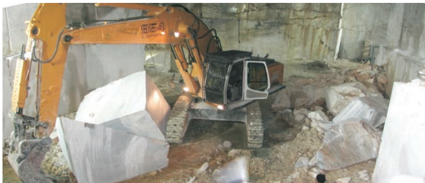
Foto 4 - ricostruzione rappresentativa della situazione del cantiere al momento dell'incidente
