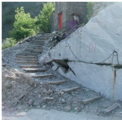
Foto 11 - esempio di passaggio attrezzato con traverse in legno per il raggiungimento di una cabina elettrica
