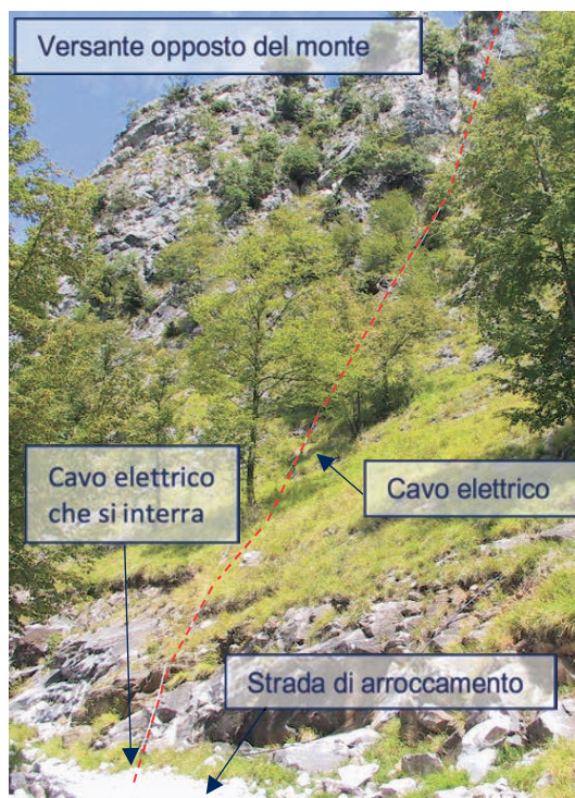
Foto 7 - in rosso rappresentazione grafica della stesura del cavo elettrico
