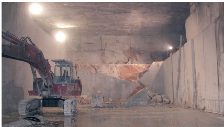
Foto 1 - vista di un cantiere della cava di marmo in sotterraneo
