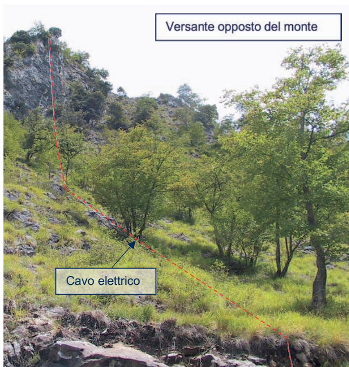
Foto 6 - in rosso rappresentazione grafica della stesura del cavo elettrico
