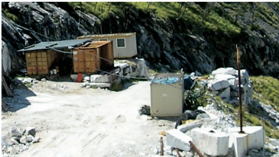
Foto 2 - area servizi e generatore
