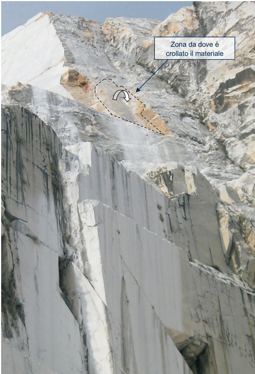
Foto 2 - area di distacco del materiale franato
