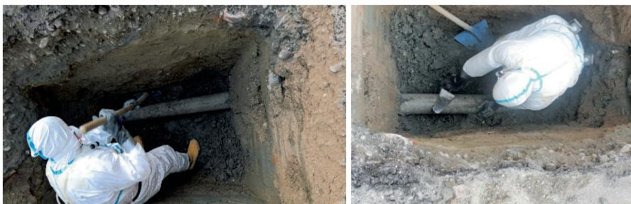
**Figura 14** - Messa a giorno delle tubazioni in cemento amianto mediante attrezzi manuali.
