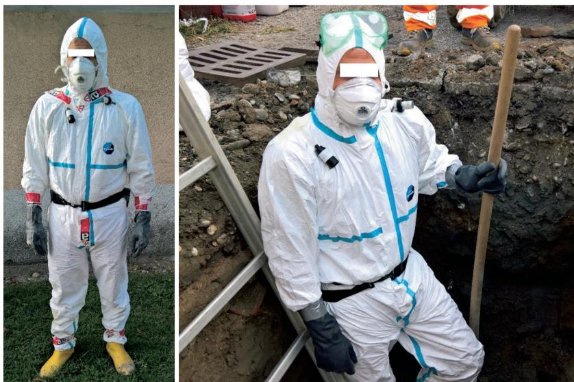
**Figura 12** - Operatore con appositi Dispositivi di protezione individuale.
