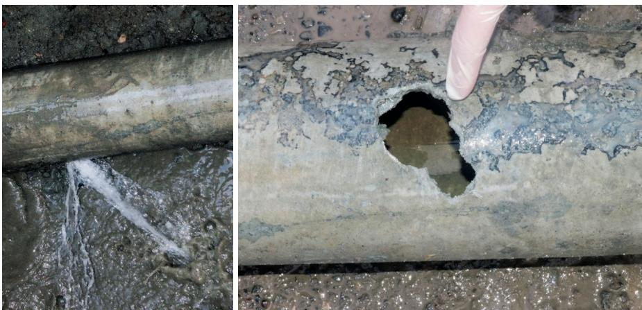
**Figura 2** - Tubazione idrica in cemento amianto lesionata.
