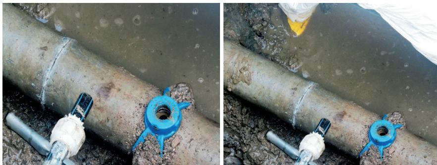
**Figura 16** - Particolare del punto di derivazione.
