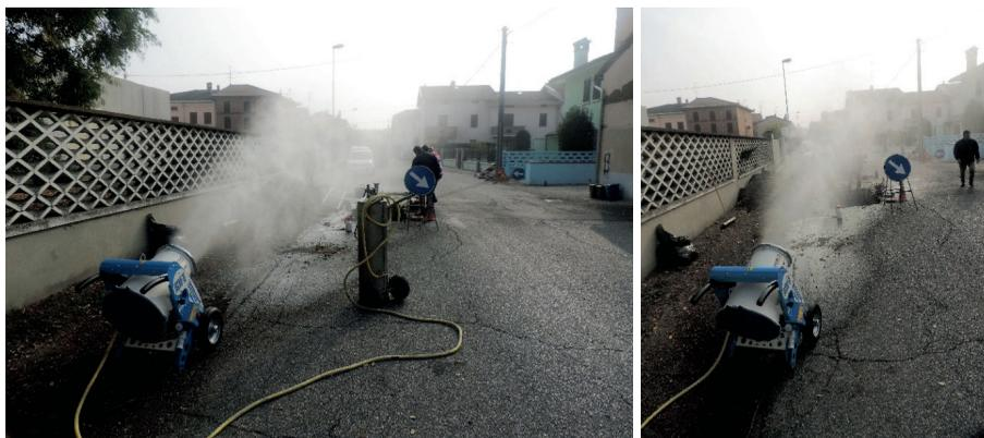
**Figura 5** - Cannone nebulizzatore nell'area d'intervento.
